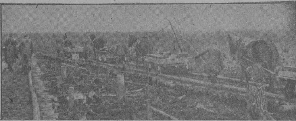
Durch zerschossenes und aufgewühltes Sumpfgelände führt eine Holzbahn zur Hauptkampflinie südlich des Ladogasees. Tag und Nacht rollt auch hier der Nachschub für die kämpfende Truppe. PK-Aufnahme: Kriegsbericht Götz (Atl.)
