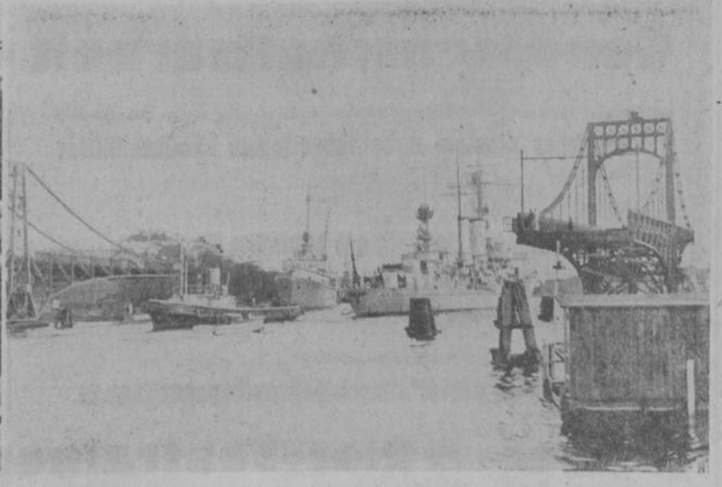
Ein Kriegsschiff passiert die Wilhelmshavener Kaiser-Wilhelm-Brücke, die größte Drehbrücke des Kontinents
