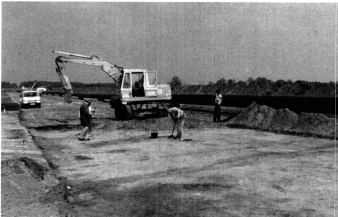
Abb. 8: Dötlingen FStNr. 370, Gde. Dötlingen, Ldkr. Oldenburg Grabungsfläche auf der Gasleitungstrasse mit Siedlungsbefunden der Römischen Kaiserzeit als dunkle Verfärbungen im Vordergrund.
