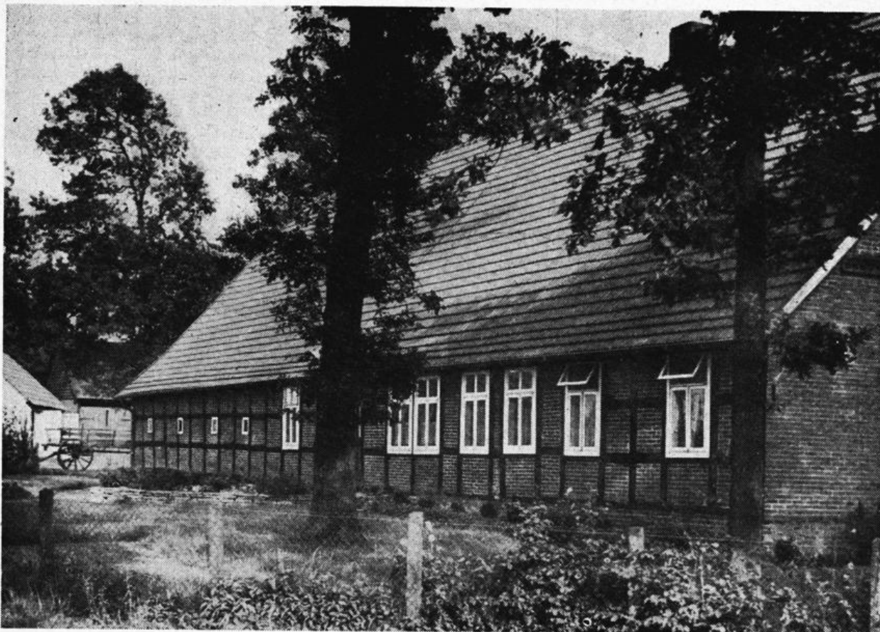
Abb. 3: Gesamtseitenansicht des Hauses Scheper-Stuke, Südlohne vor dem Umbau von einem rückwärtigen Standort aus. Die Länge des Hause hatte im Durchblick der aufgelockerten Eichen unbedingt einen wirkungsvollen Fluß. Die starre Dachfläche wurde durch die Bäume gemildert. Die Fenster sind unglücklich geformt. Ihre Reihung ist ohne jedes Leben. Die schmale Seitentür tritt völlig zurück.
