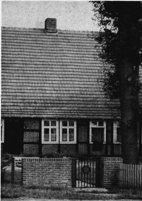
Abb. 5: Blick auf Seitentür und Kammerfach des alten Hauses Scheper-Stuke, Südlohne vor dem Umbau. Etwas zu gewaltsam setzt das wuchtige Dach sich auf die Seitenwand. Es fehlt dem Ganzen jedes gestalterische Leben. Das neue Eisenpförtchen an der Straße im Vordergrund vermag daran nichts zu ändern. Die unglückliche Fensterform wird sehr sinnfällig spürbar, ja sie verstärkt den toten und kalt abweisenden Eindruck des unfreundlichen Bildes.
