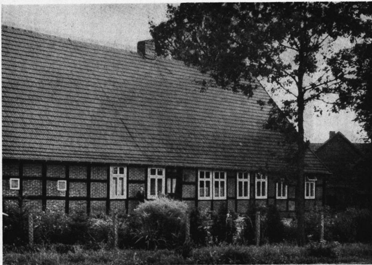
Abb. 1: Gesamtseitenansicht des Hauses Scheper-Stuke, Südlohne vor dem Umbau. Sie zeigt vorne eines der üblichen alten Bauernhäuser unserer Heimat. Der Seiteneingang wirkt nichtssagend. Das glatte harte Dach macht einen leicht eintönigen Eindruck. Die ganze Längsfront ist bereits durch gelegentliche Veränderungen nicht mehr im ursprünglichen Zustande. Immerhin konnte man dem Hause dank seiner bevorzugten Lage eine gewisse Wirkung nicht absprechen.
