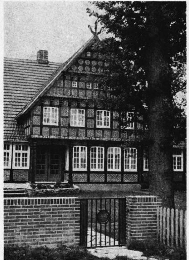
Abb. 6: Blick auf den neuen Frontspieß mit Seiteneingang des Hauses Scheper-Stuke, Südlohne. Die unscheinbare Seitentür von einst hat nun eine bedeutende Gestalt und entsprechende Umrahmung erhalten. Selbst das eiserne Pförtchen erscheint bedeutungsvoller als früher. Die hervorragende Qualität der Verzimierung und Bearbeitung des Holzes durch Meister Sieve-Leffering aus Lohne trägt viel zur ausgezeichneten Repräsentation bei. Hier ist es nicht abwegig, von einem echten Ausdruck bäuerlicher Vornehmheit zu sprechen.
