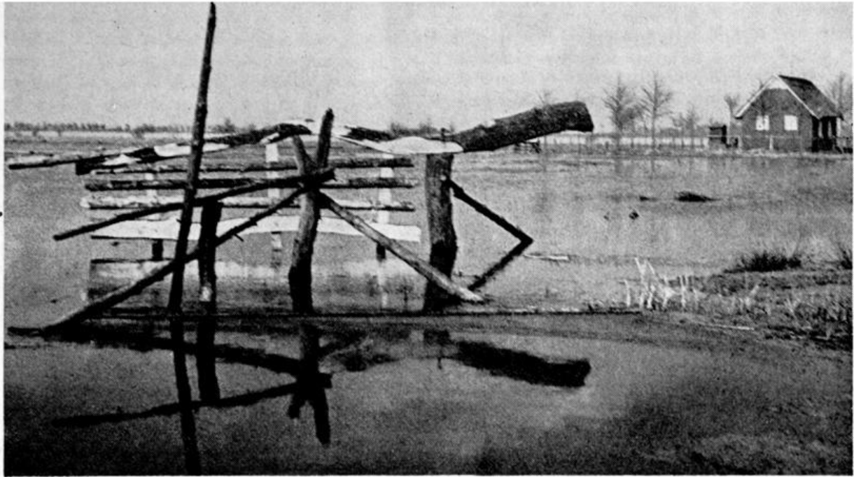
Überschwemmungen in der Nähe des neuen „Olgahafens“ am unteren Ende der Dümmerstraße vor der Eindeichung (aufgenommen 1938)
