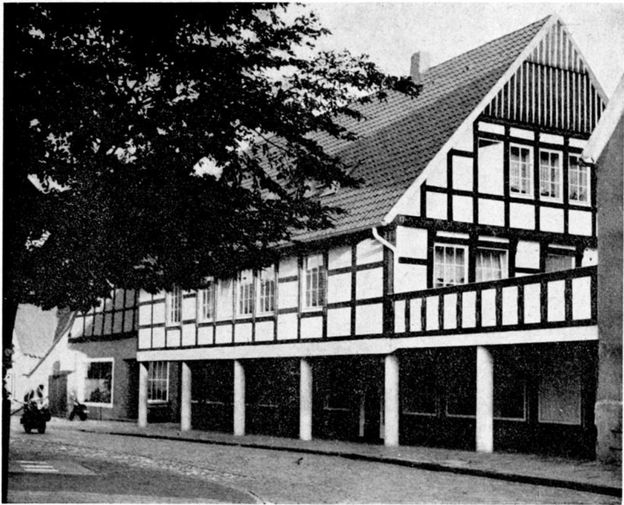
Abb. 2. Die erneuerte Küsterei am Kirchplatz in Damme
