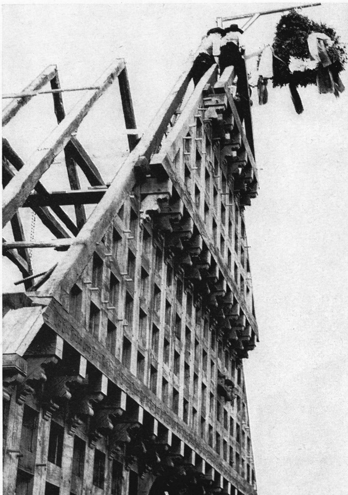
Der Richtkranz über dem wiedererrichteten Giebel des neuen Quatmannshofes im Museumsdorf
