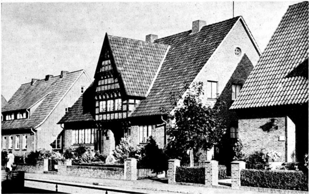
Straßenbild in Steinfeld („Wuert“). Die traufenseitig ausgerichteten Häuser erhalten durch den Fachwerkausbau des mittleren Hauses (Dr. med. Moorkamp) eine heimatlliche und städtebaulich interessante Note (Architekt: Hermann Büld, Damme). Man möchte in die einförmigen und baumodischen Wohnsiedlungen von heute mehr solche zeitlosen Akzente hineinwünschen.
