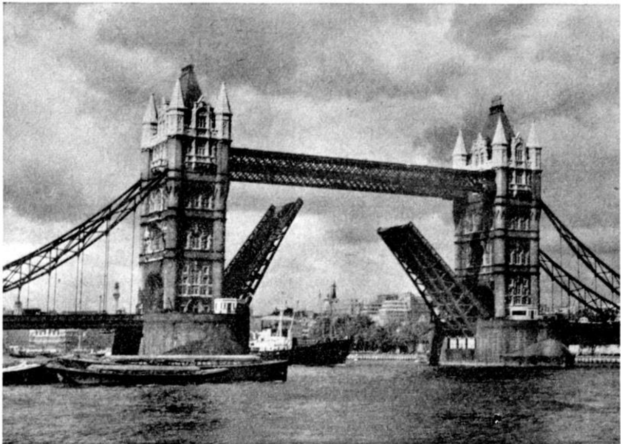
Die Themsebrücke in London
