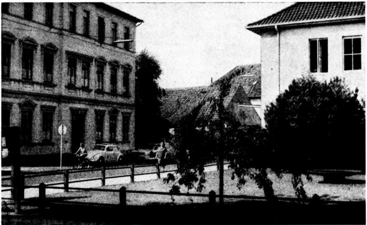
Die Oldenburgische Landesbank (rechts) und das derzeitige Haus der Landwirtschaft (links) an der Großen Straße in Vechta stehen auf Parzellen, wo die früheren Gebäude zeitweilig postalischen Zwecken dienten. Aufn. Alwin Schomaker-Langenteilen
