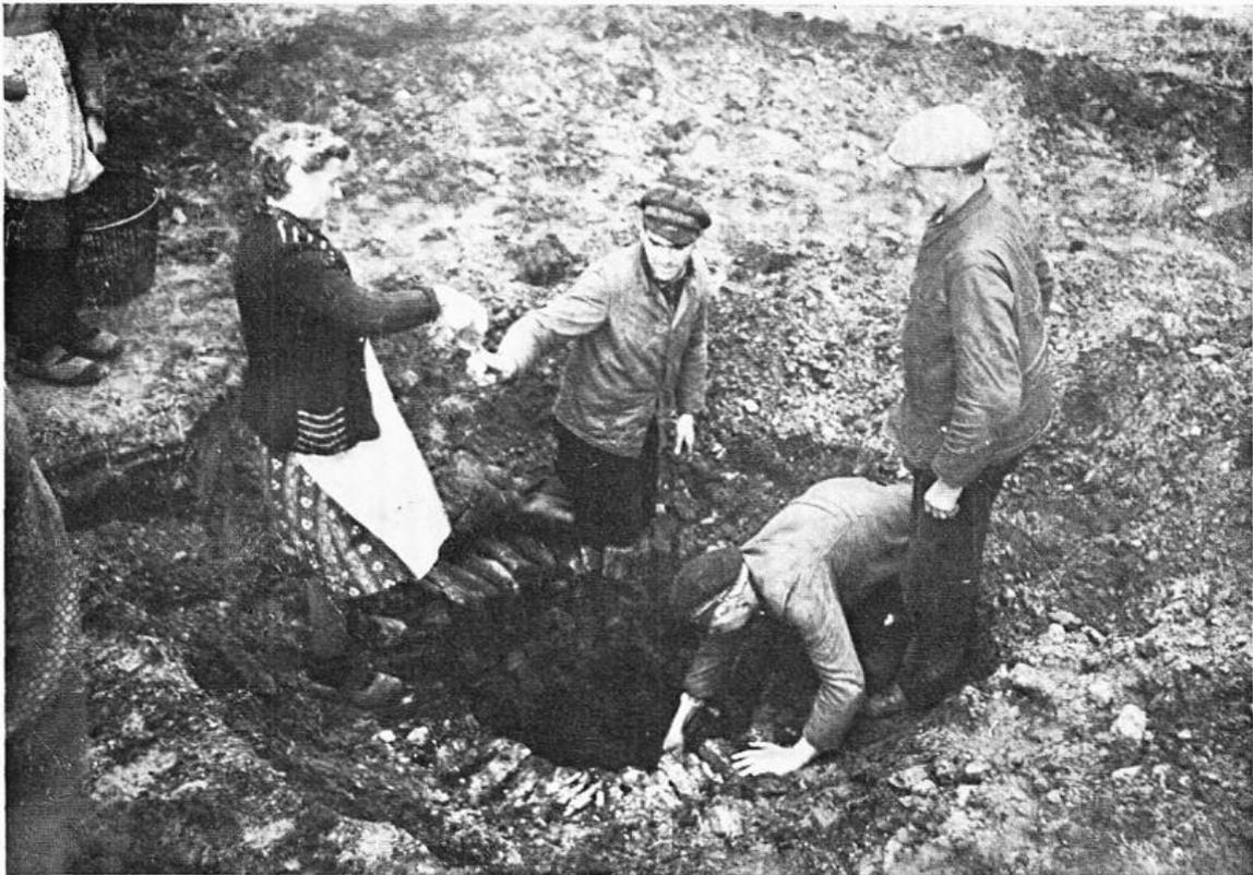
Gegen Abend ist der Brunnen so weit fertig, daß der Bauer die Restarbeiten leicht selbst erledigen kann. Nach einigen Tagen hat der Sand den Torfschacht zu einem festen Filter zusammengedrückt. Der Innendurchmesser des Brunnens hat sich um ein Drittel auf einen Meter verringert. Das Wasser ist rein und klar, nur ein bißchen gelblich.
