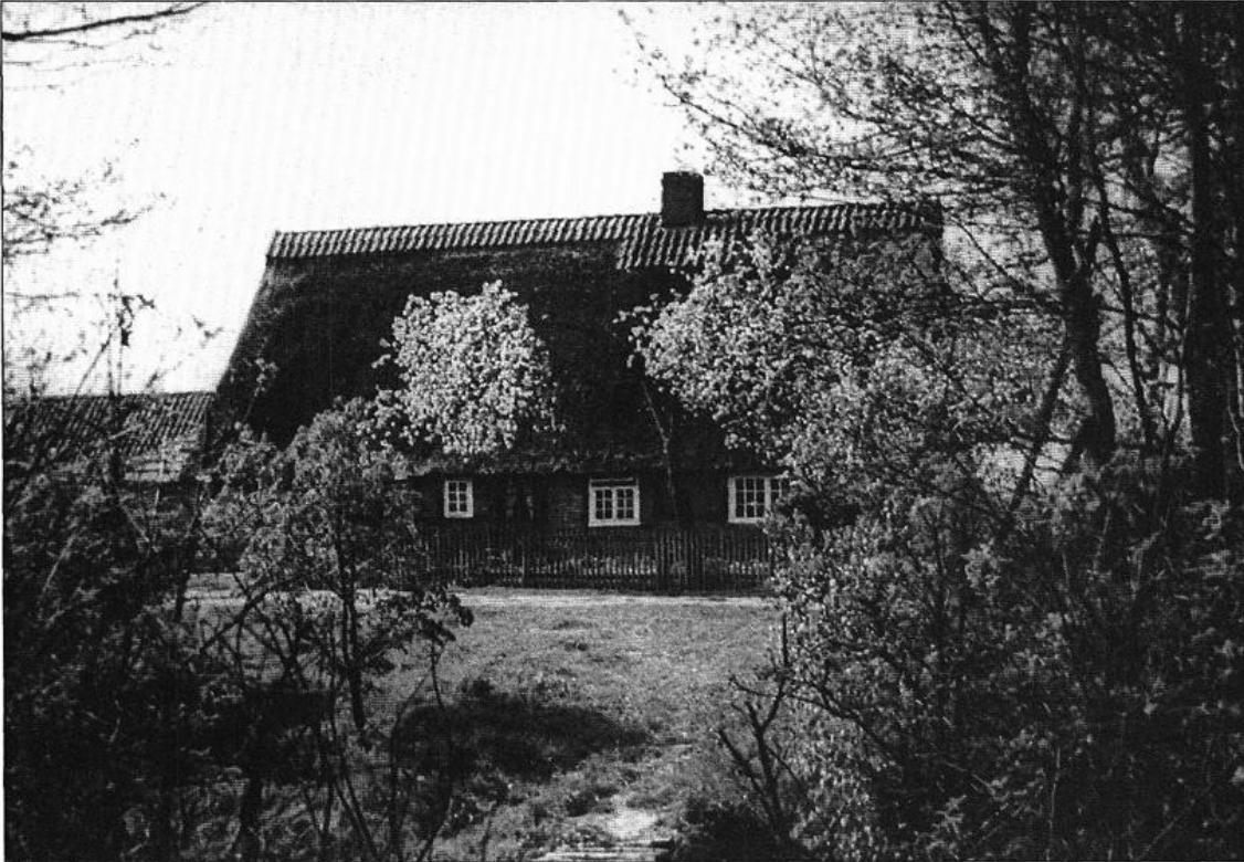
Das Fachwerkhaus im Hasetal, an dem während des Umbaues das Mauswiesel beobachtet wurde.
