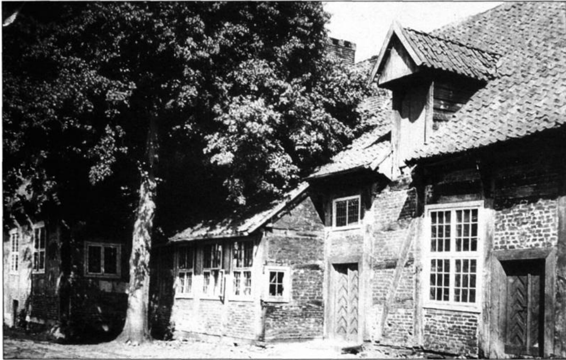
Gutshaus Gr. Arkenstede in Brokstreek vor der Translozierung ins Museumsdorf Cloppenburg.
