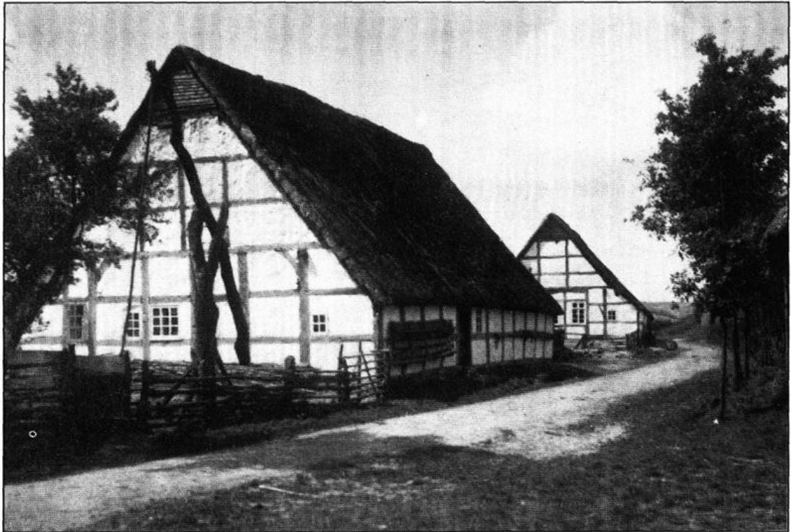
Heuerhäuser in Bergfeine
