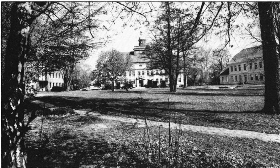
Im Stadtpark Cloppenburg bauten die Oldenburger 1805 das „Herrschaftliche Landgerichtshaus“ als Amtssitz und Landgericht (rechts), 1909 wurde ein neues Verwaltungsgebäude für Amtsgericht und Amtsverwaltung gebaut (Mitte), 1960 ein eigenes Kreishaus (links).
