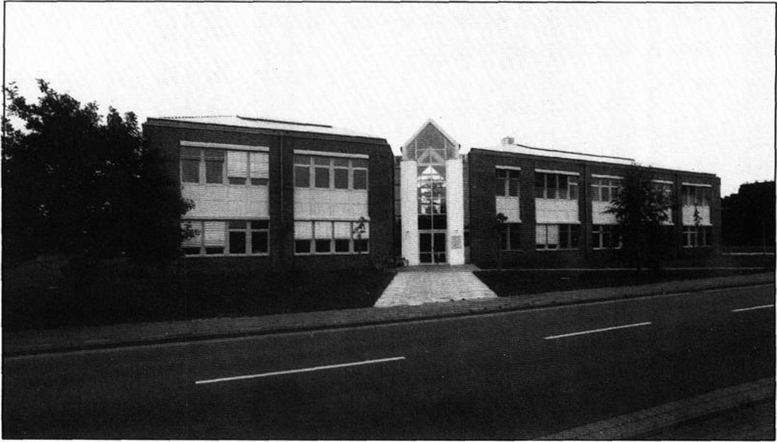
ISPA-Gebäude (Aufnahme von der Straßenseite)
