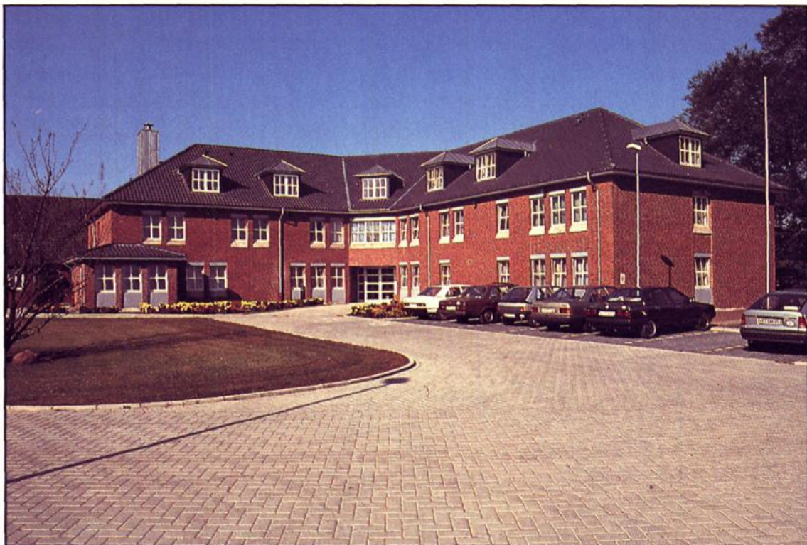
Das neue Verwaltungsgebäude der Jugendanstalt Vechta-Falkenrodt, mit Aufnahme- und Sanitätsabteilung
