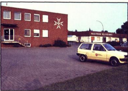
Rettungsstation des Malteser-Hilfsdienstes
