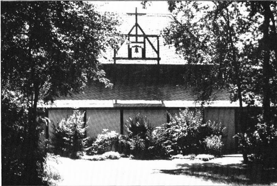
Ehemaliges Gemeindezentrum Steinfeld, heute beim evang. Freizeitzentrum an den Ahlhorner Fischeichen
