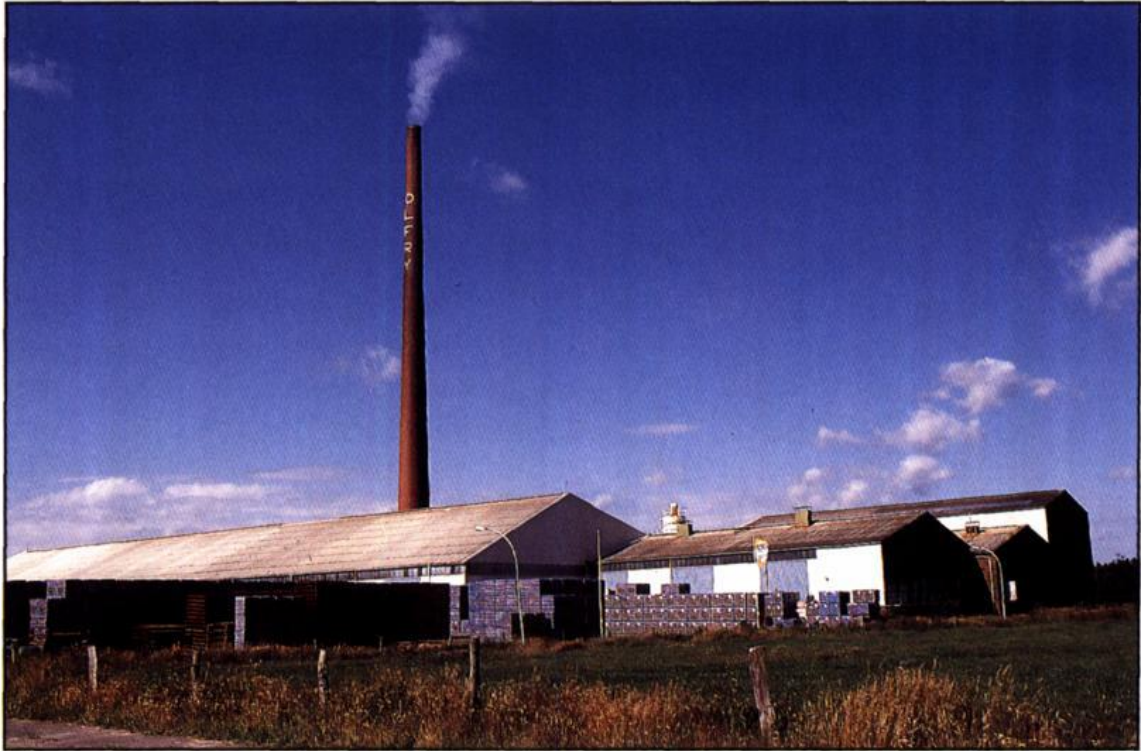
Die Ziegelei von Frydag, Hagen, wurde seit 1908 immer weiter ausgebaut und modernisiert. In dem mit Erd- und Mülldeponiegas geheizten Tunnelofen werden jährlich 45 Millionen „Olfry-Ziegel“ gebrannt
