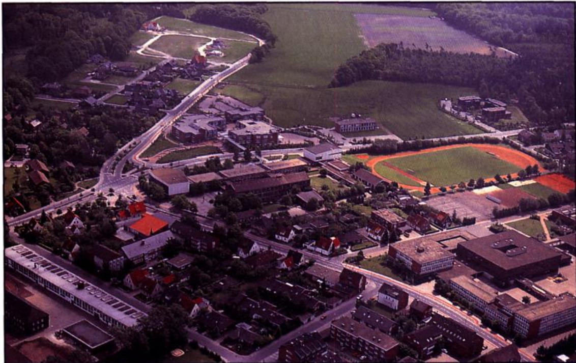
Ein Bildungszentrum der Stadt Vechta: Im Hintergrund die Universität Osnabrück, Standort Vechta, vorne links die Katholische Fachhochschule Norddeutschland, vorne rechts das Schulzentrum Vechta-Süd.
