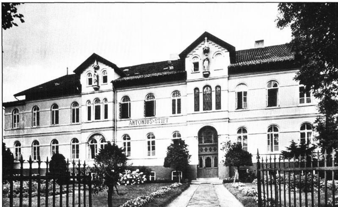
Das Antoniusstift nach dem Erweiterungsbau
