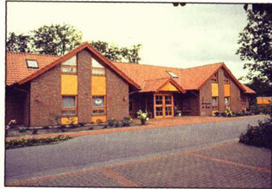
Kindergarten St. Ludger, Neuscharrel
