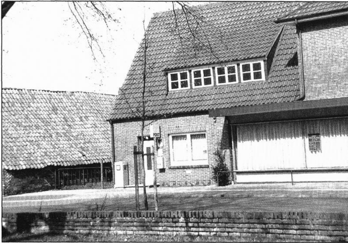
Bild 9: Poststelle Harkebrügge Juni 1992
