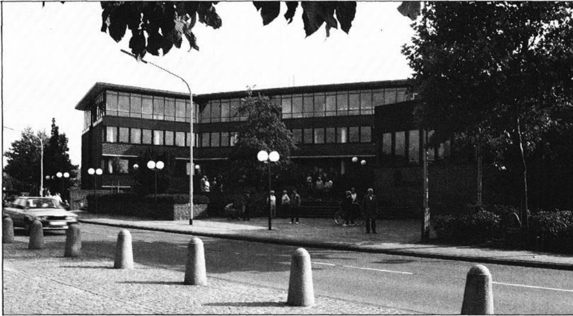
Das Rathaus in Lohne nach der Aufstockung des 2. Obergeschosses.
