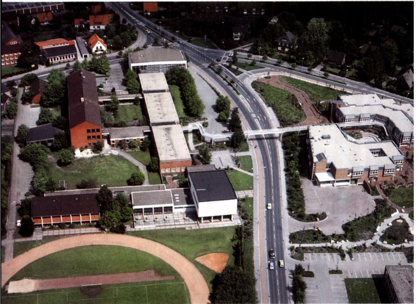
Luftbild von der derzeitigen Universität Osnabrück, Standort Vechta; ab 1. 1. 1995 Hochschule Vechta Foto: Dr. Seele, Vechta
