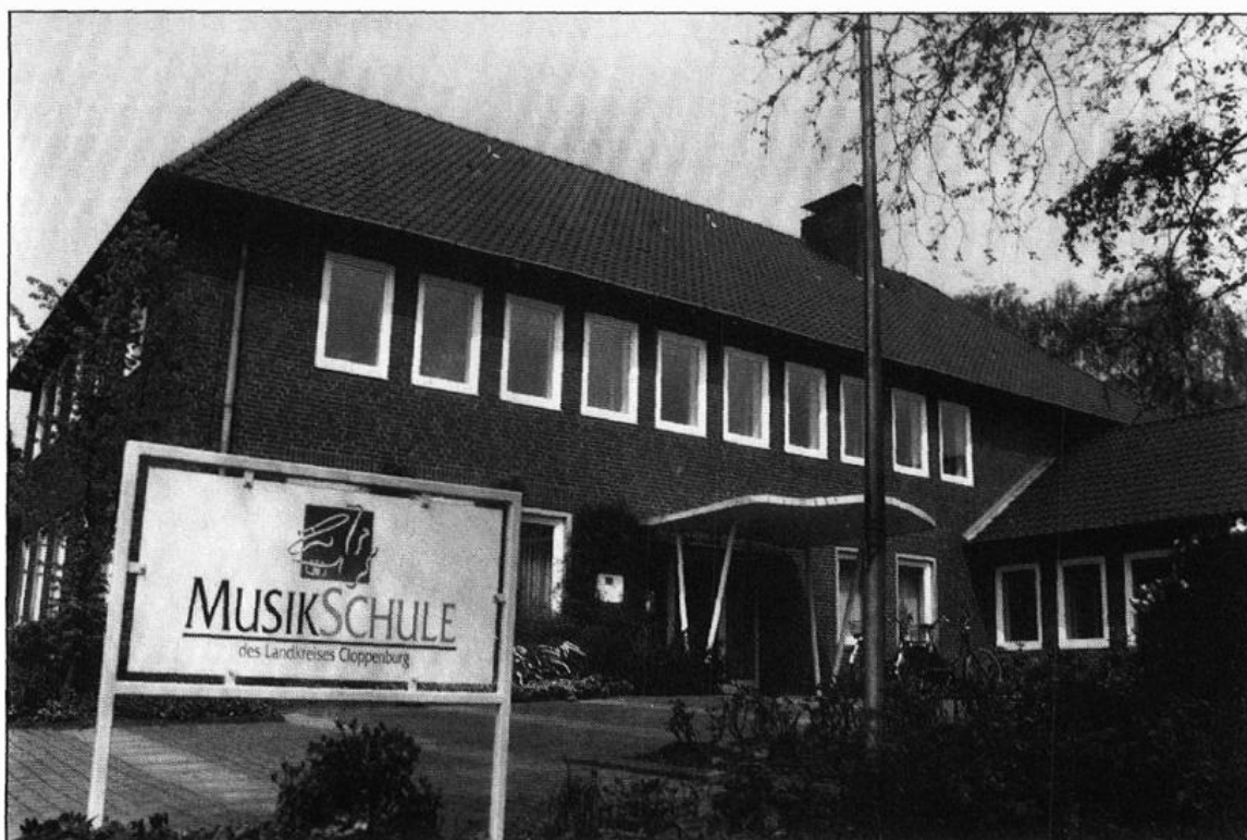
Unterrichtsgebäude der Kreismusikschule Cloppenburg
