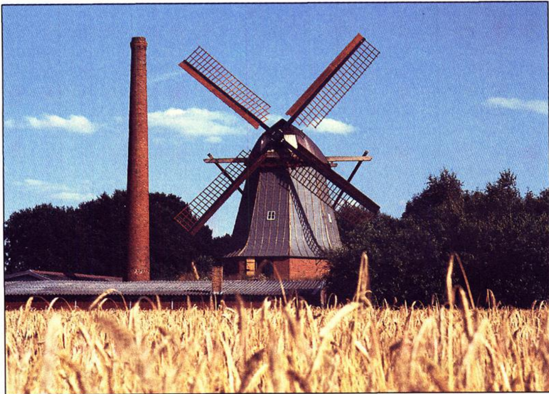
Die 1993/94 restaurierte Windmühle in Liener. Links im Bild der Schornstein des Backhauses.
