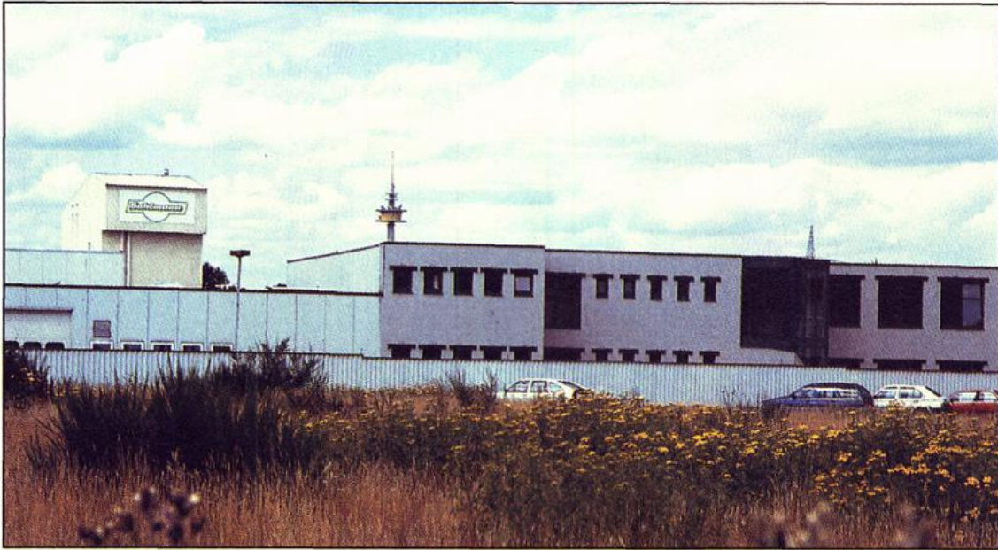
Gewerbegebiet Lindern: Das Firmengebäude der Versandschlachtereier und des Spezialmischfutterwerkes Bahlmann. Im Hintergrund die Spitze des 158 m hohen Postturmes.
