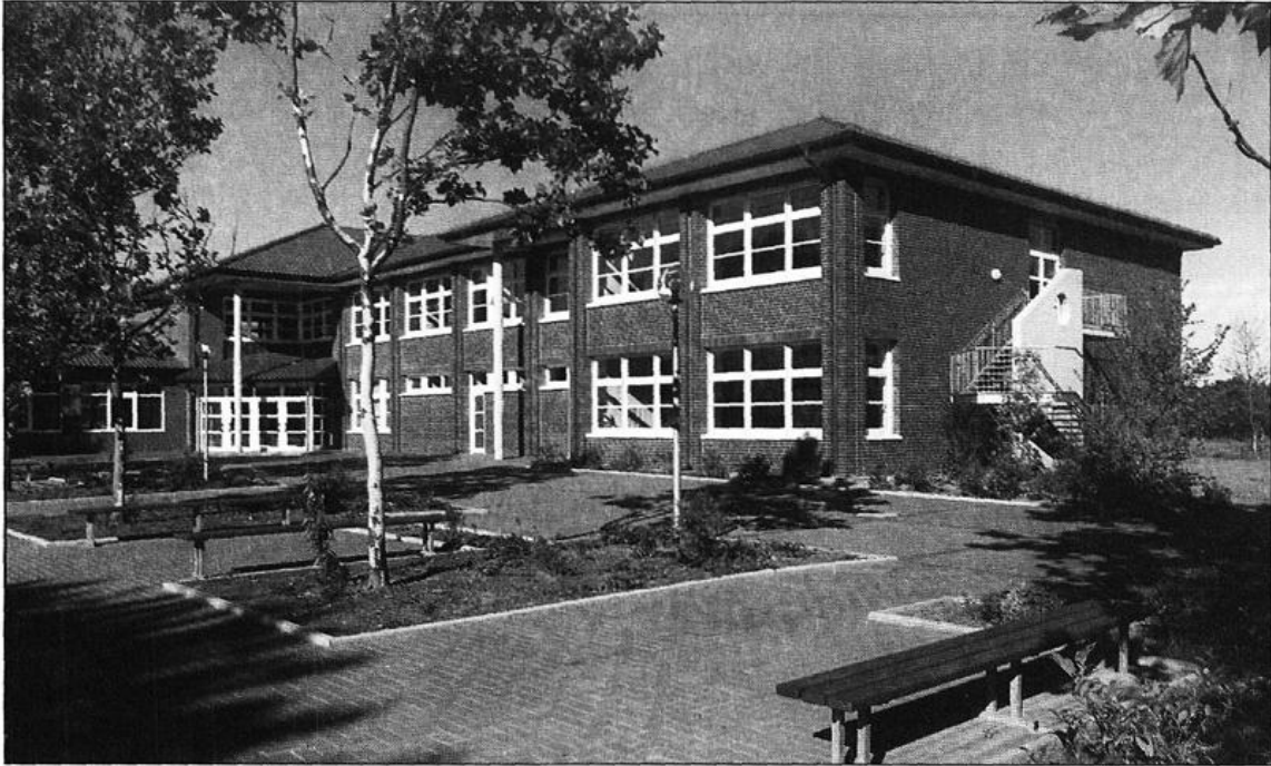
Erweiterungsbau der Haupt- und Realschule mit Orientierungsstufe in Bösel
