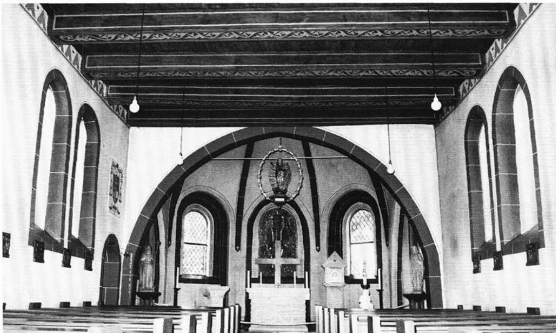
Innenansicht der Klosterkapelle in Bokelesch: Saal mit Flachdecke, polygonaler Chor mit Strebepfeilern und spitzbogigen Fenstern, im Inneren ein fünfteiliges Bandrippengewölbe.
