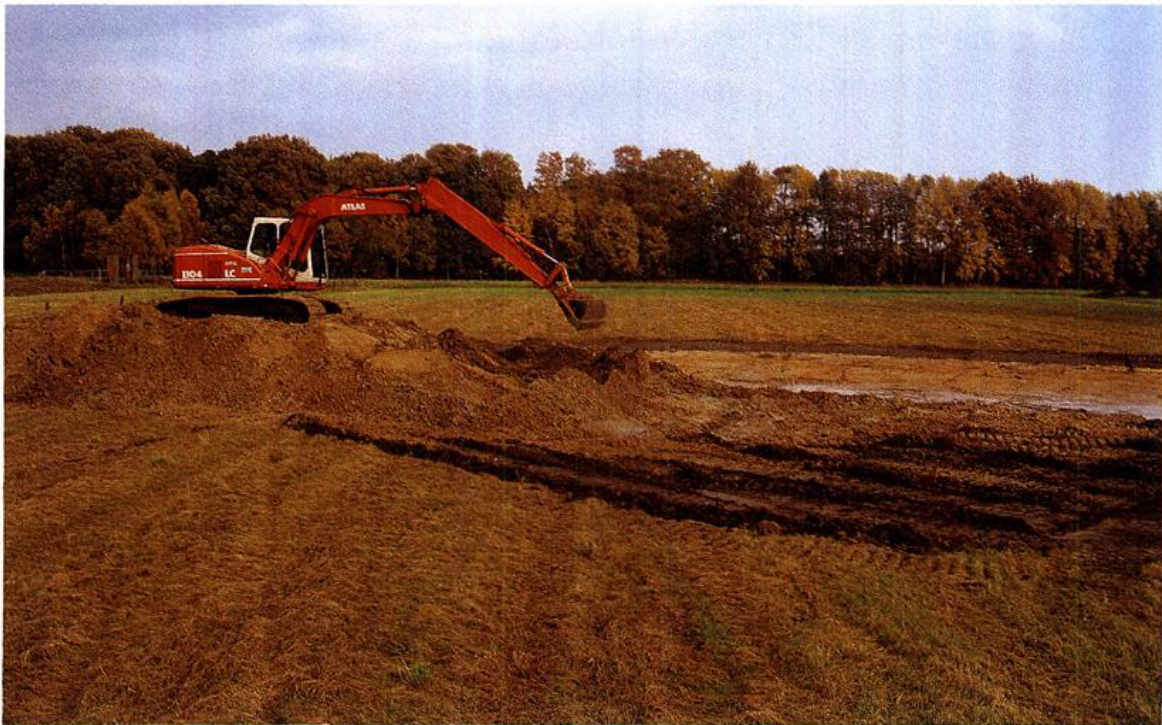
Ein Biotopteich in der Bauphase
