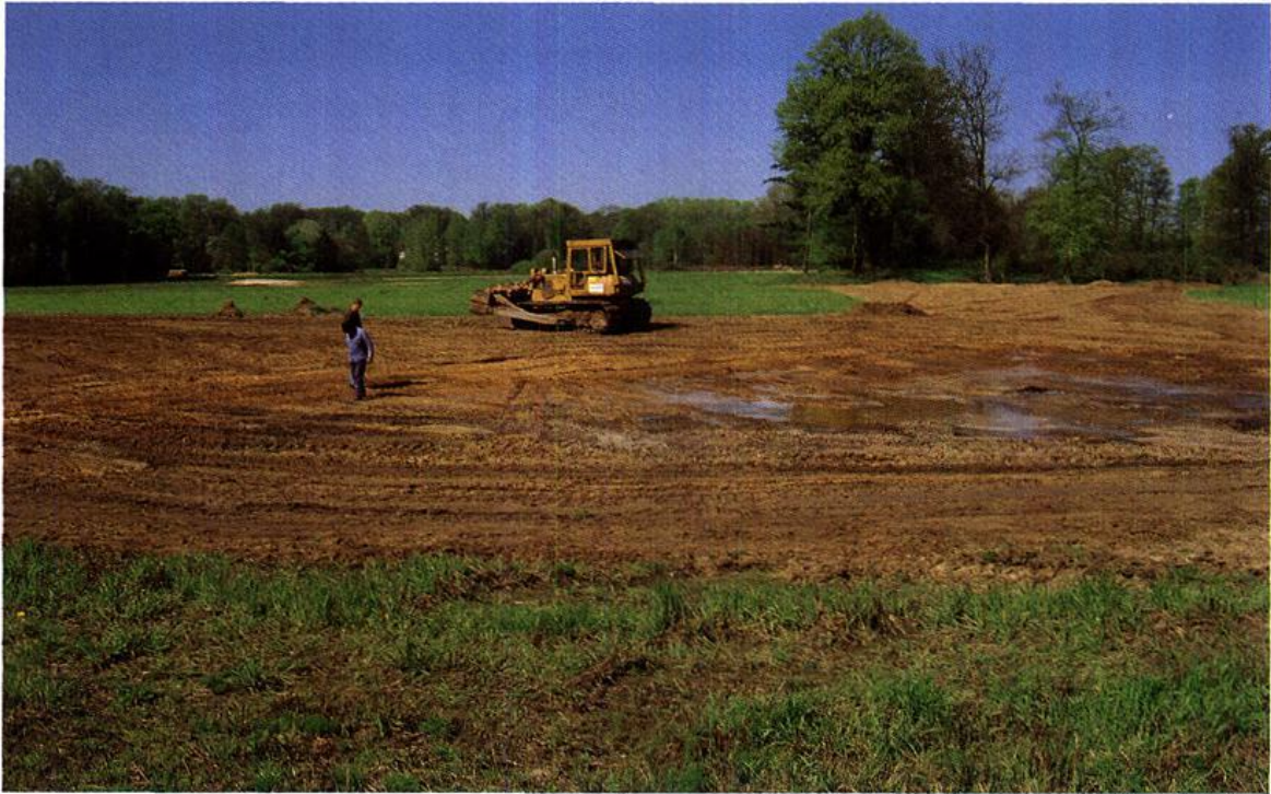
Neuanlage einer Senke mit wechselnden Wasserständen
