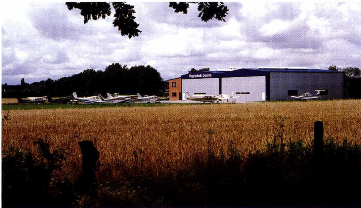
Neubau der Flugzeugreparaturwerkstatt Feseck auf dem Gelände des Flugplatzes in Damme/Rottinghausen.
