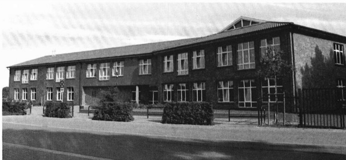
Die neue Grundschule in Molbergen.
