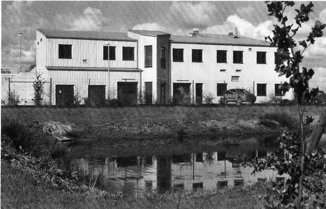
Blick auf die neue Kläranlage an der Dinklager Straße
