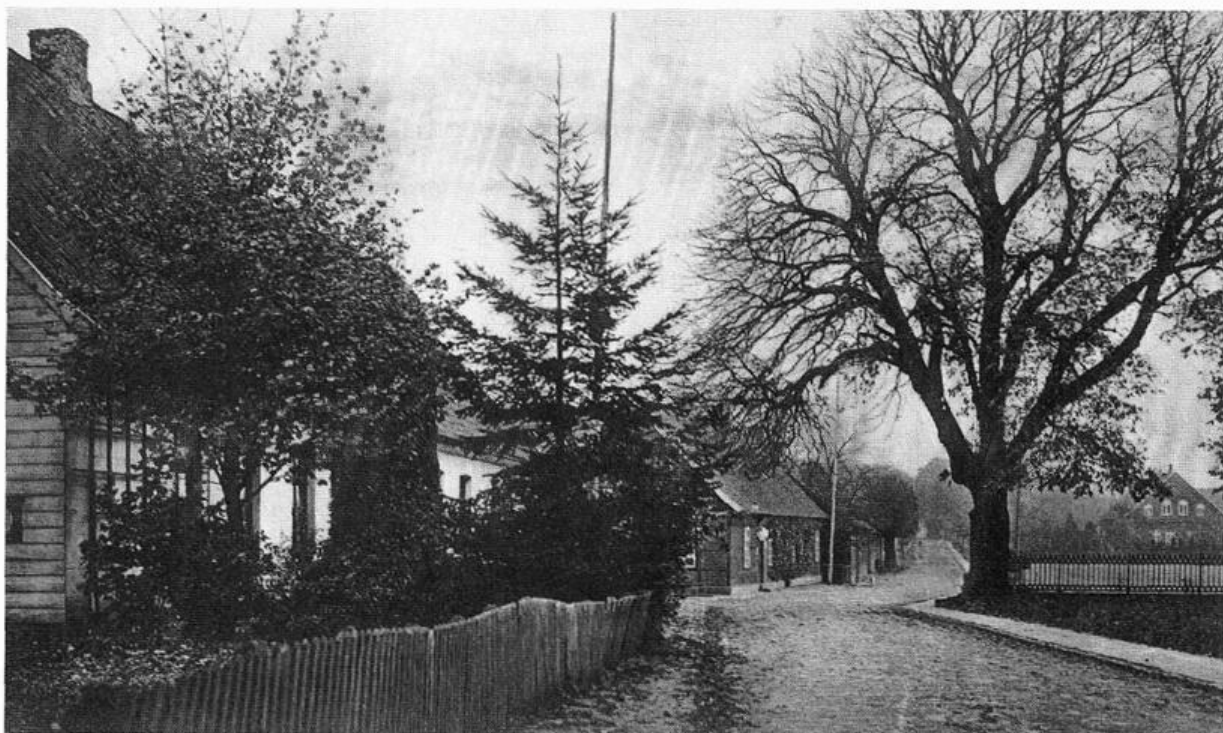
Das erste Haus vorne links ist jenes, in dem der Kirchspielsvogt und Notar Awick gewohnt hat. Spätere Eigentümer waren Schrand und heute Osterkamp. Die Aufnahme der Wallstraße stammt aus dem Jahr 1910.
