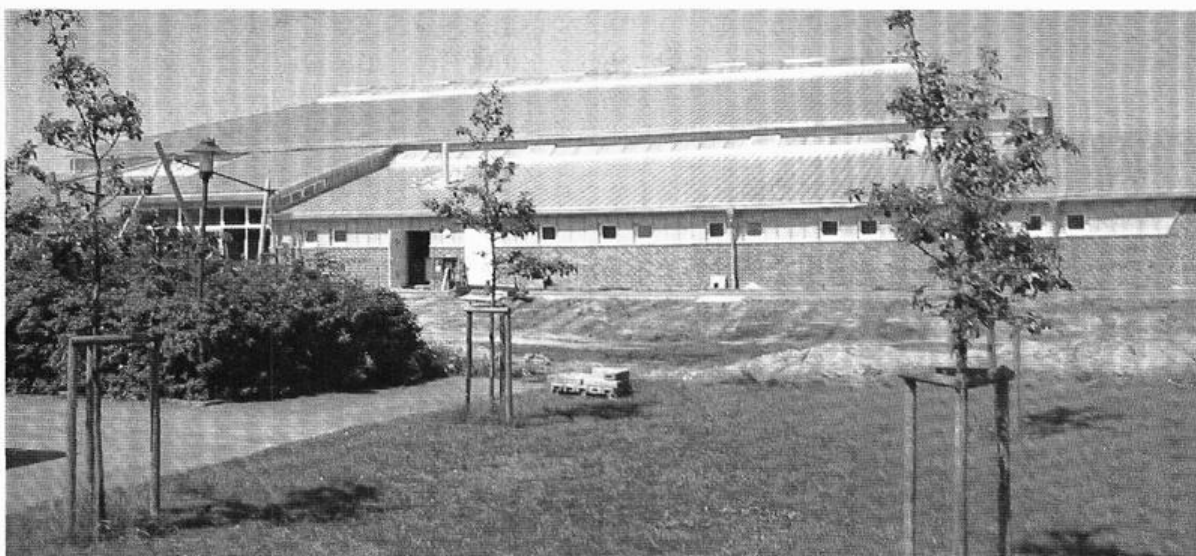
Neubau der Dreifeld-Sport- und Veranstaltungshalle in Molbergen
