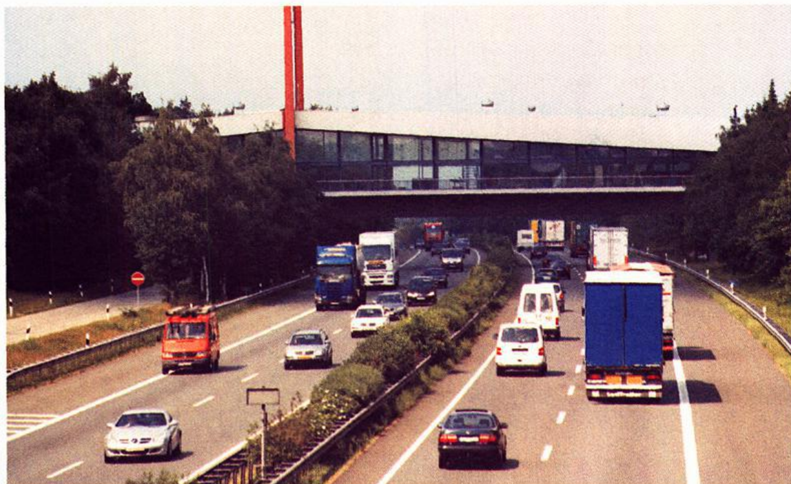
Brückenrestaurant „Dammer Berge“
