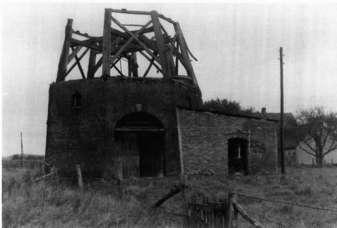
Abb. 6: Garlings Mühle in der Abbruchphase, aufgenommen am 06.10.1974
