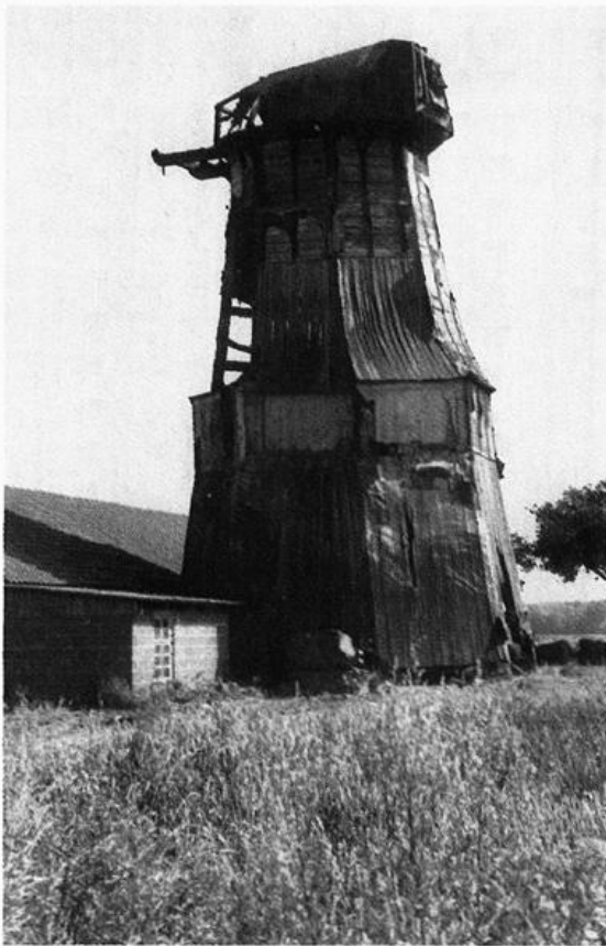
Abb. 7: Middelbecks Mühle in Westerlütten war ebenfalls eine Galerie-Holländer-Mühle mit vier Segelgatterflügeln. Das Foto entstand kurz vor dem Abbruch der Mühle, als die Flügel schon länger abgenommen waren und der Korpus schon einen baufälligen Eindruck machte.
