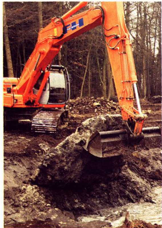
Abb. 5: Abbrucharbeiten an einem Stahlbeton-Sohl Absturz. Ganz deutlich sind die großen Mengen an Beton zu erkennen, die zuerst einmal aus dem Gewässer entfernt werden mußten.
