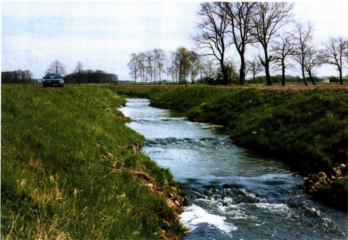
Abb. 6: Neue Sohlgleite im Unterlauf des Calthorner Mühlbaches
