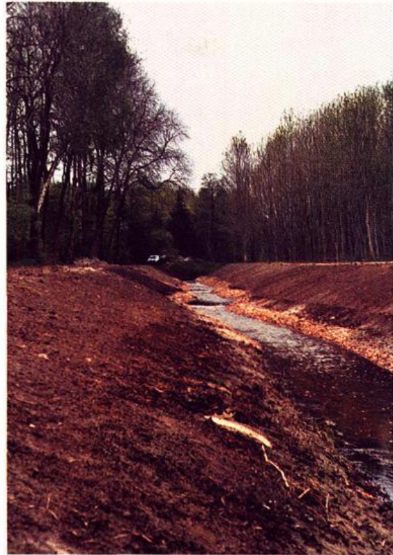
Abb. 7: Umgestalteter Bachabschnitt mit Anlage von Laichplätzen. Das Foto wurde direkt nach der Fertigstellung aufgenommen. Hier wurde eine Absturzhöhe von 60 cm durch eine Sohlgleite ersetzt.
