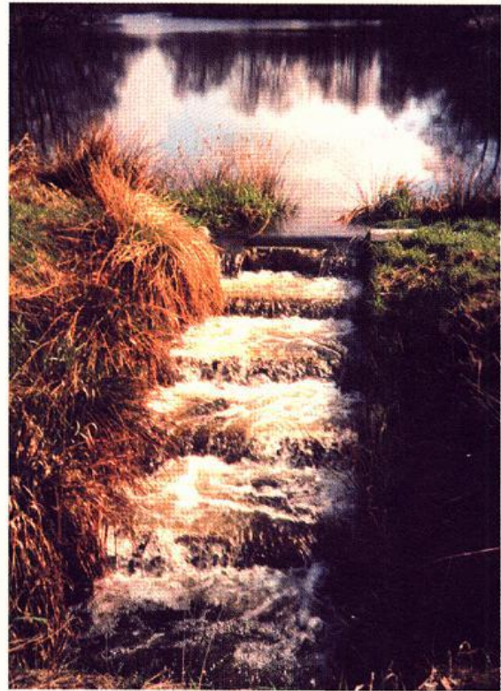
Abb. 5: Die „Fischtreppe“ am 1990/91 erneuerten Staudamm der „Lethetalsperre“ im wasserreichen Jahr 1994 in Betrieb
