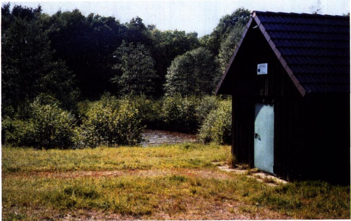
Abb. 7: Das „Pumpenhaus“ mit „Abpumpbecken“
