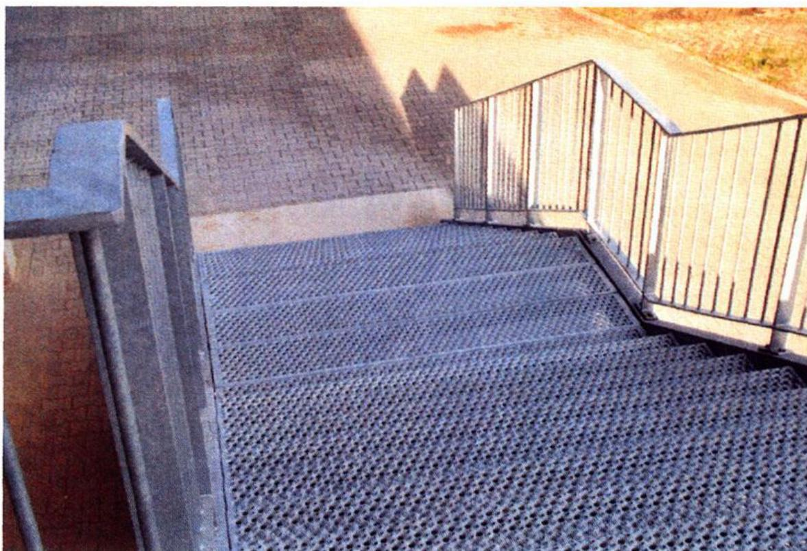
*Feuerverzinkte Stahltreppe mit Stufen und Podestbelägen von Graepel*
