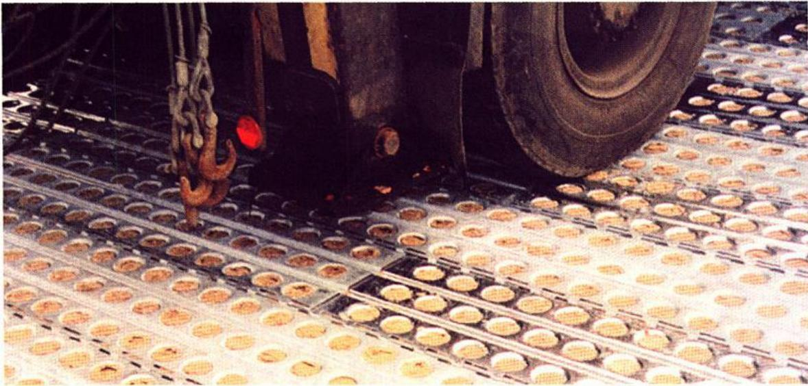
*Unbefestigte Plätze und Wege werden mit diesen wiederaufnehmbaren Bodenblechen zeitweilig oder auf Dauer selbst mit schweren Fahrzeugen befahrbar.*
