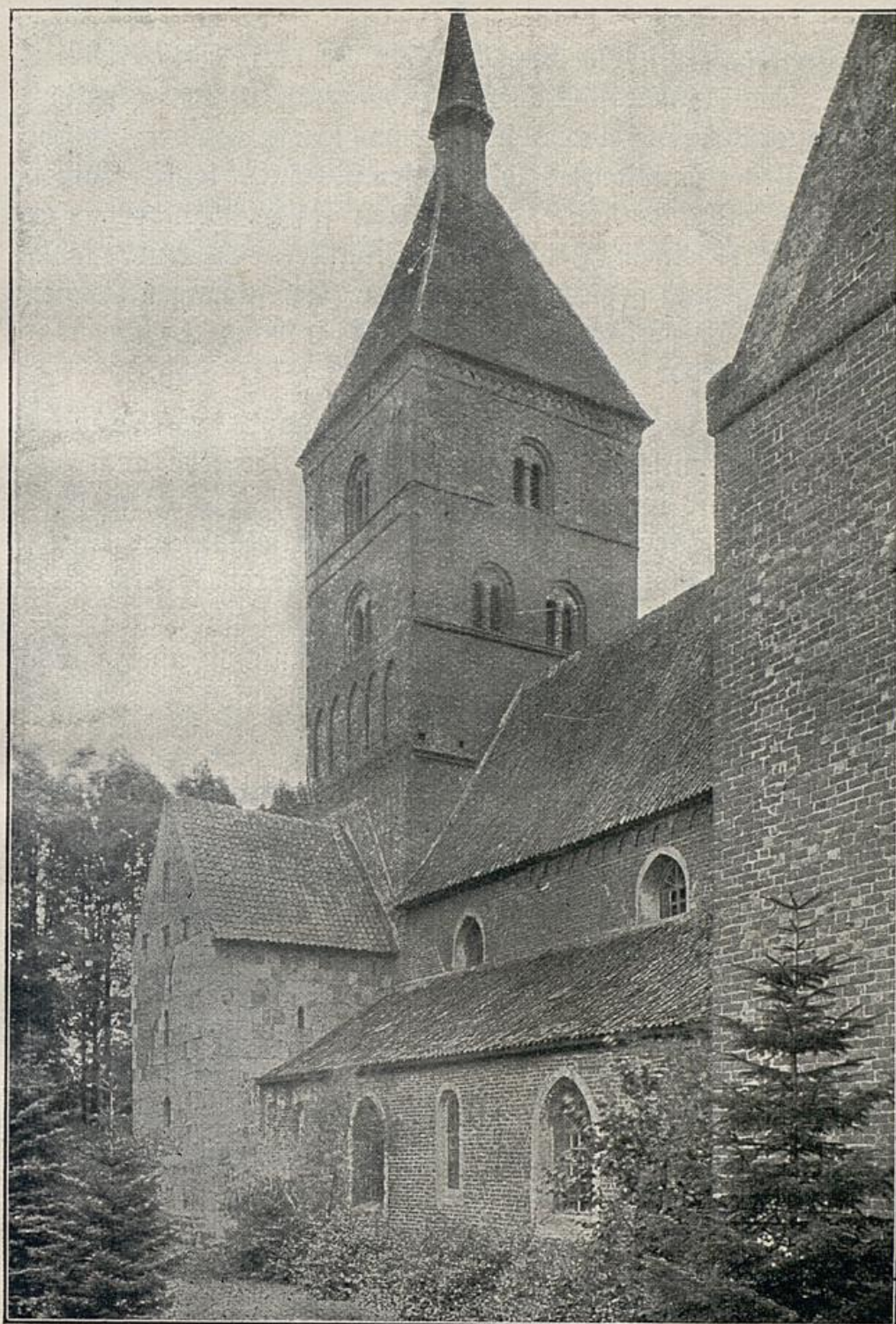
Alexanderkirche in Wildeshausen nach der Wiederherstellung.
