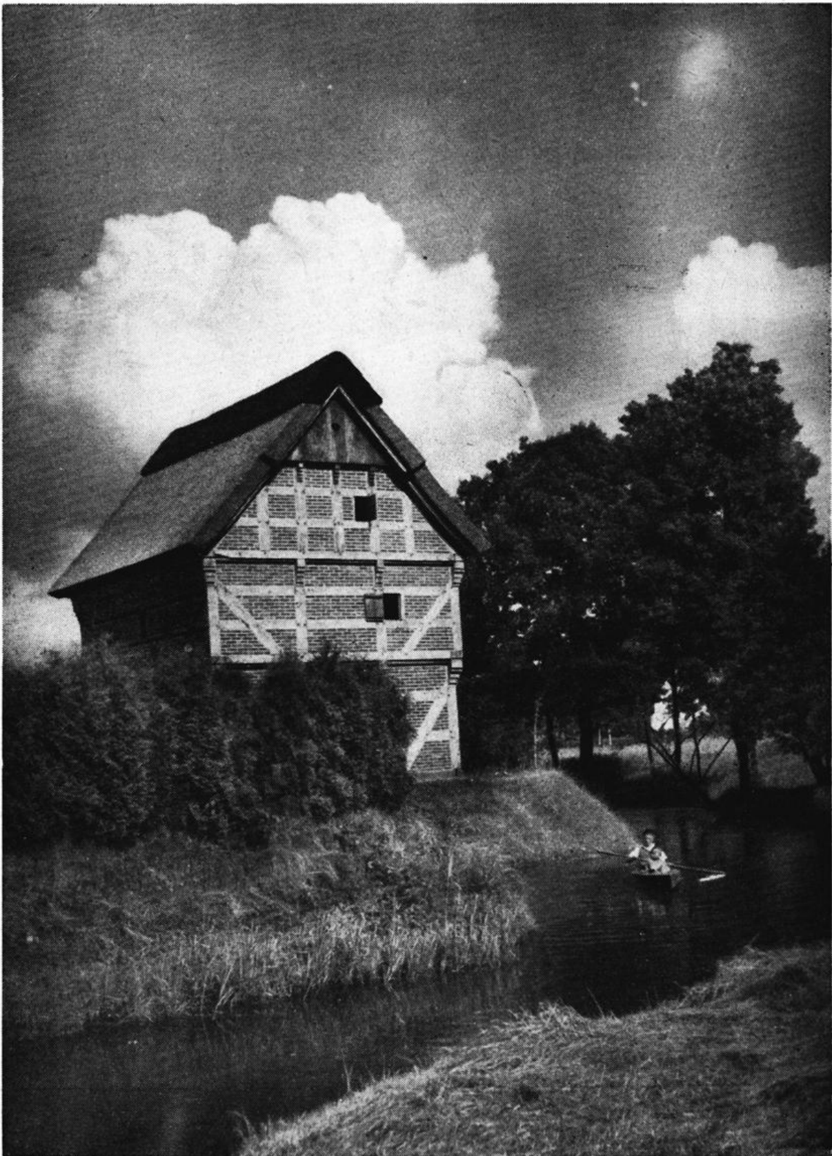
Dieser schöne, zweistöckige Speicher steht heute ebenfalls im Museumsdorf. Ursprünglich zählte er, wie das Backhaus von 1614, zu den Nebengebäuden des Nording'schen bew. Westermann'schen Bauernhauses in Norddöllen (Gem. Visbek). Wie das Bild zeigt, hat dieser Speicher im Museumsdorf auf einer Insel Platz gefunden. Auch in Norddöllen stand er ehemals auf einer solchen Insel.
