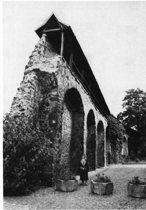
Abb. 9: Die aus Findlingen und Kalkmörtel gebaute mittelalterliche Umfassungsmauer der Mecklenburger Stadt Templin mit Wehrgang (Höhe über acht Meter); dies Mauerwerk ist nur haltbar wegen des mächtigen Rundbogen-Stützsystems (mit Ziegelstein-Verblendung).
