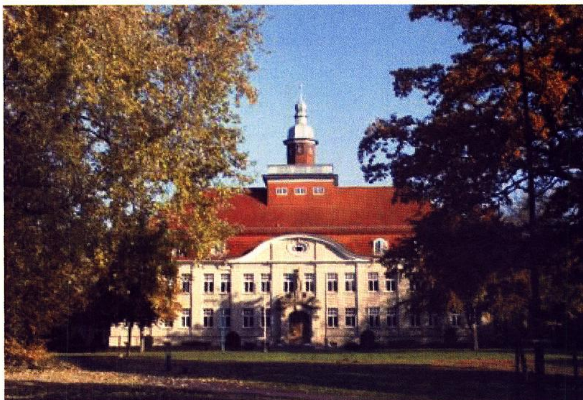
Abb. 2: Das im ersten Jahrzehnt des letzten Jahrhunderts errichtete Amts- und Amtsgerichtsgebäude
