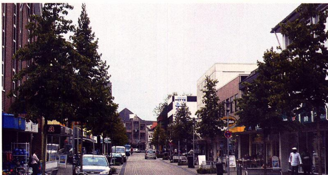
Neuausbau der Bahnhofstraße
