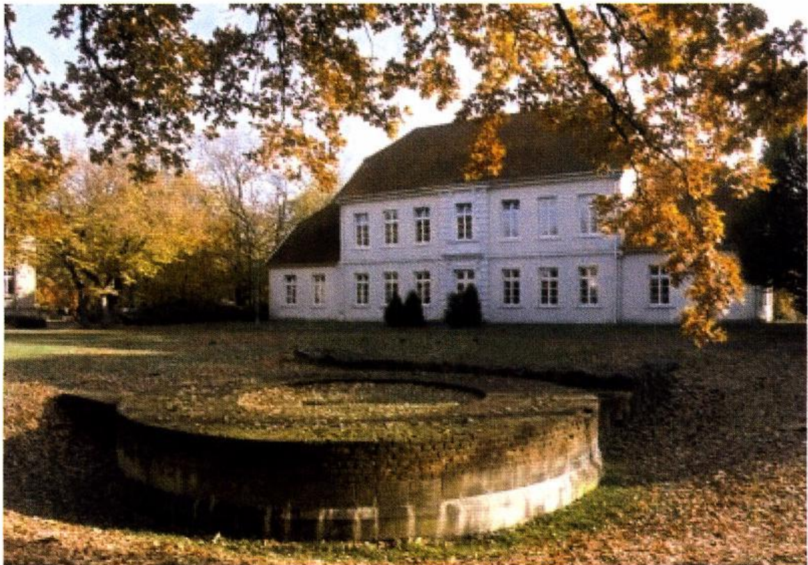
Abb. 1: Das alte Amtshaus auf dem ehemaligen Burggelände
