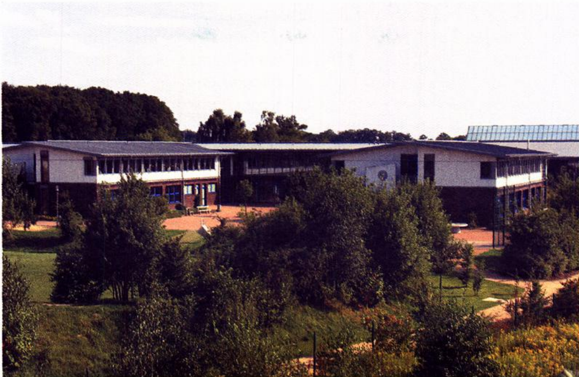
Schule mit Dreifeldhalle an der Leharstraße (Stand 2007)
