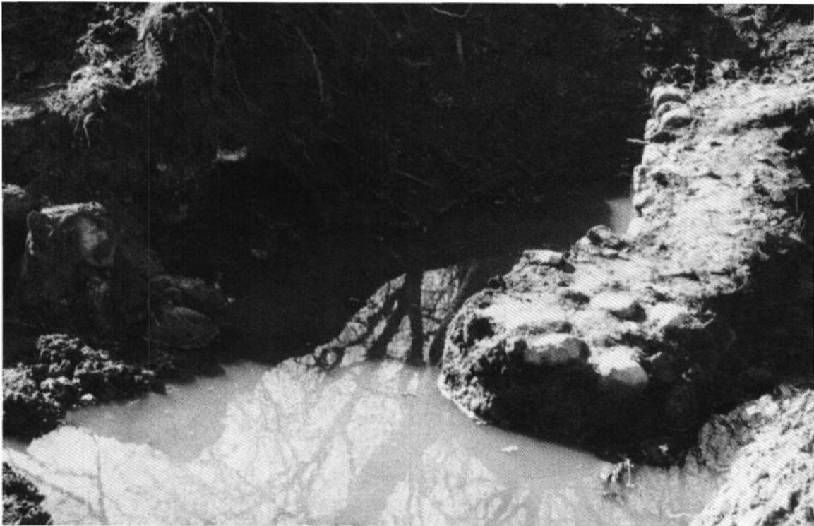
Abb. 8c: Das ca. ein Meter hohe Findlingsmauerwerk der Vorburg-Ringmauer mit Blick auf die Mühlenstraße; erkennbar ist die Biegung der Umfassungsmauer im östlichen Teil der Vorburg - s. Abb. 7a und 7b
