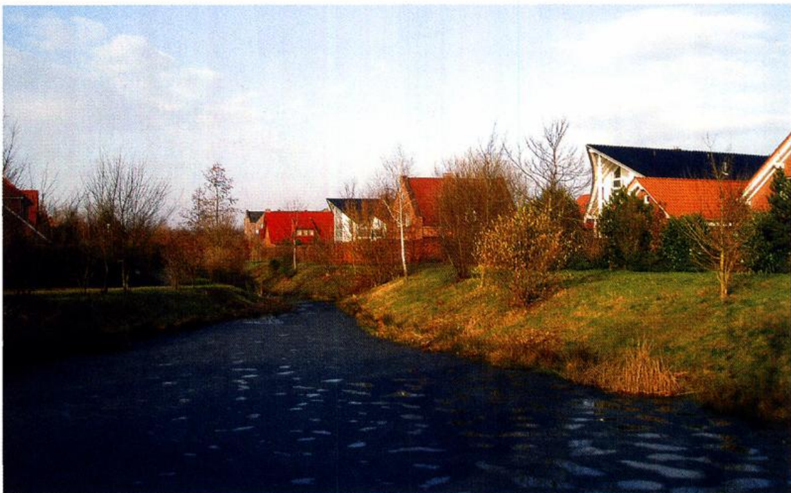
Abb. 9: Häuser mit Rückhaltebecken an der St.-Stephan-Straße Foto: B. Hinrichs (Februar 2007)
