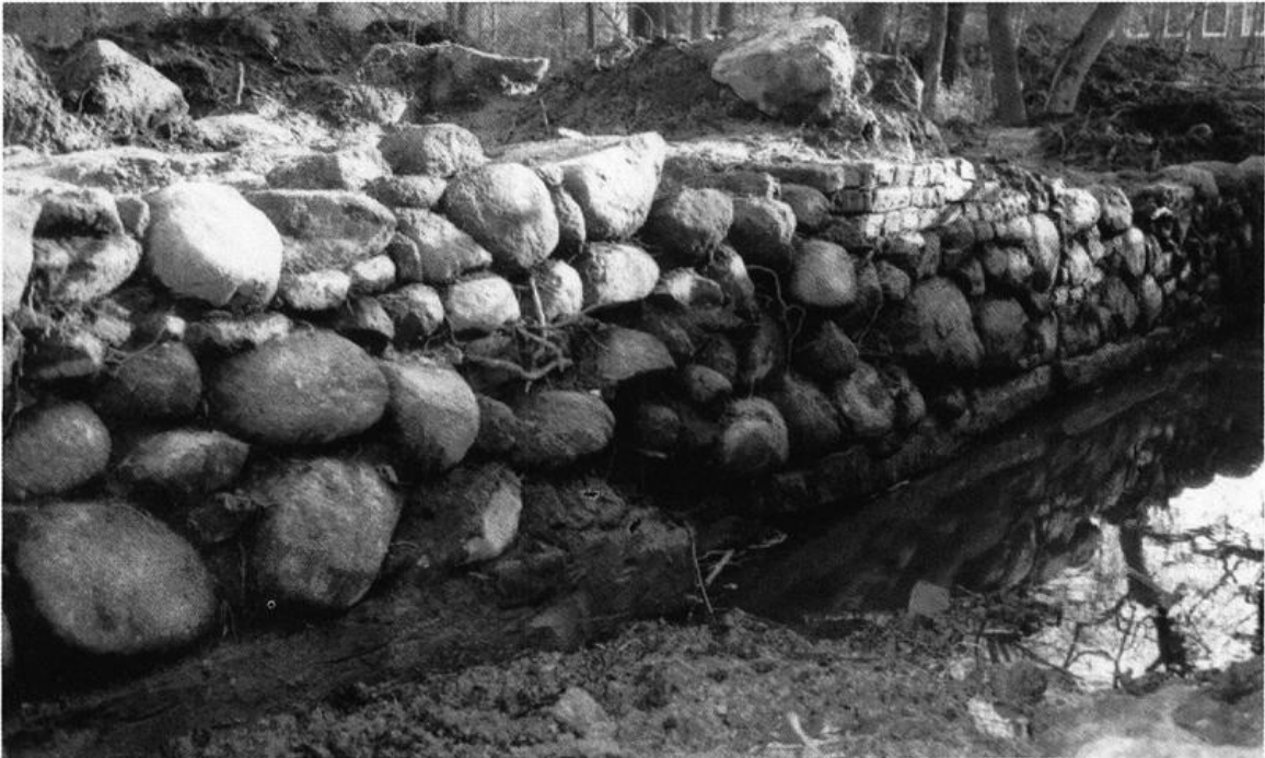
Abb. 8a: Das ca. ein Meter hohe Findlingsmauerwerk der Vorburg-Ringmauer; Innenseite der Anlage mit Blick auf die ehemalige Hauptburg („Parkhotel“) - s. Plan Abb. 2, 7a u. 7b
