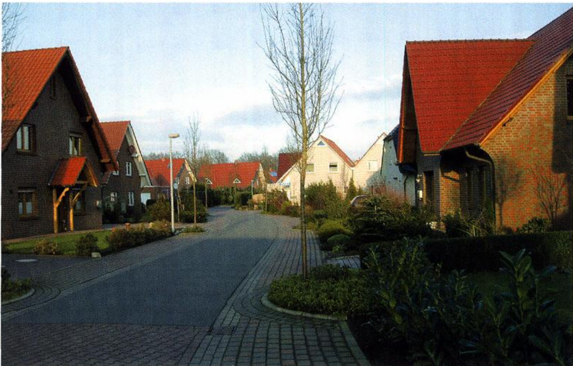
Abb. 18: Adolph-Kolping-Ring in Richtung Heinrich-Brauns-Straße
