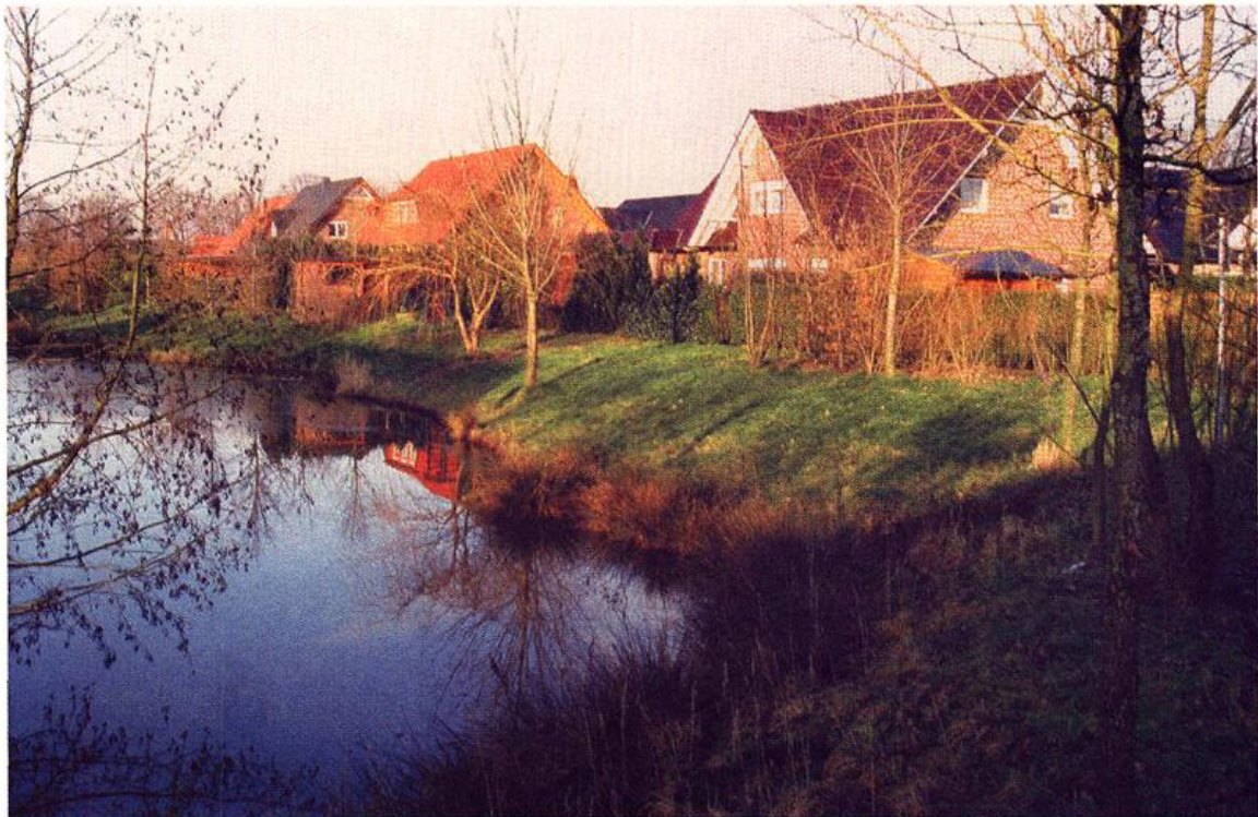
Abb. 15: Häuser an der Theodor-Fliedner-Straße mit Rückhaltebecken Foto: B. Hinrichs (Februar 2007)
