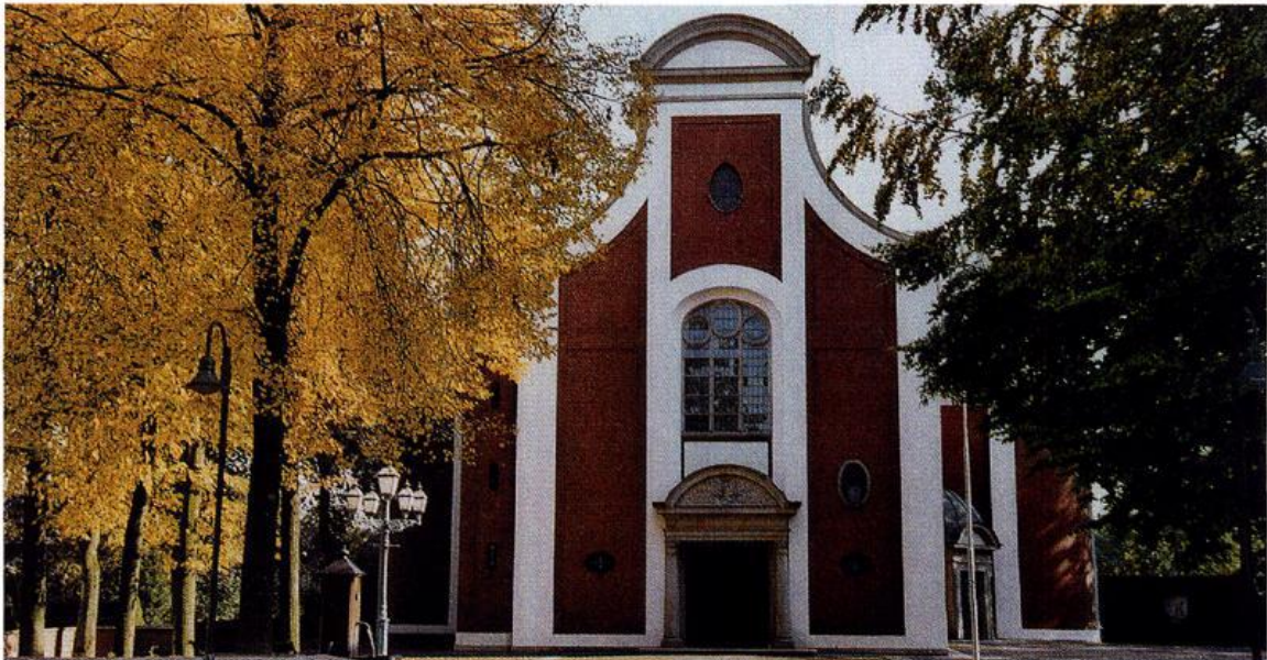
„Basilika Minor“ im Ortsteil Bethen
