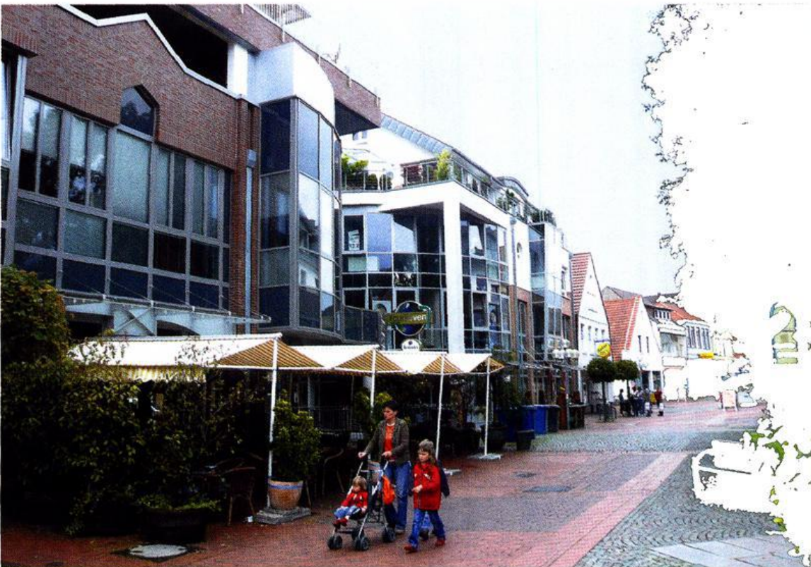
Neubau an der Mühlenstraße
