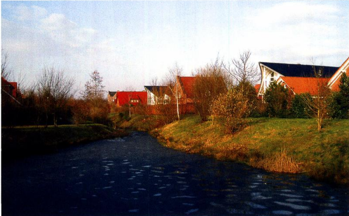
Abb. 9: Häuser mit Rückhaltebecken an der St.-Stephan-Straße Foto: B. Hinrichs (Februar 2007)
