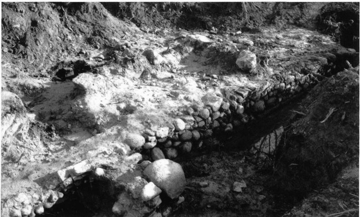
Abb. 8b: Das ca. ein Meter hohe Findlingsmauerwerk der Vorburg-Ringmauer; Innenseite der Anlage mit Blick auf die ehemalige Hauptburg („Parkhotel“) - s. Plan Abb. 2, 7a u. 7b
