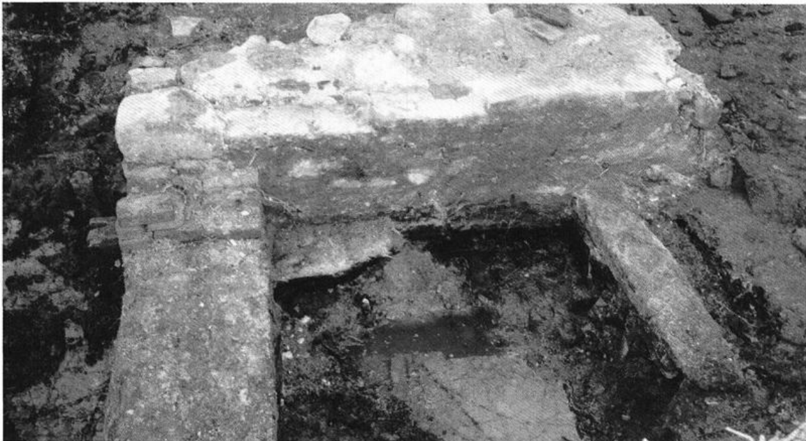
Abb. 8d: Das von schweren waagerechten Bohlen und einem senkrechten Pfahlrost abgestützte Mauerwerk aus Ziegelsteinen des Kaminfundamentes des Rentmeisterhauses - s. Abb. 5
