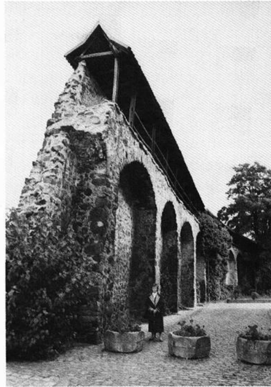
Abb. 9: Die aus Findlingen und Kalkmörtel gebaute mittelalterliche Umfassungsmauer der Mecklenburger Stadt Templin mit Wehrgang (Höhe über acht Meter); dies Mauerwerk ist nur haltbar wegen des mächtigen Rundbogen-Stützsystems (mit Ziegelstein-Verblendung).
