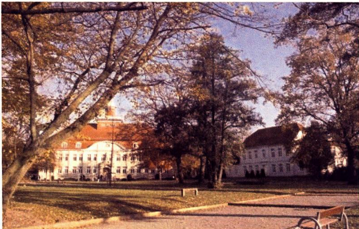
Abb. 4: Die Gebäude des heutigen Amtsgerichtes
