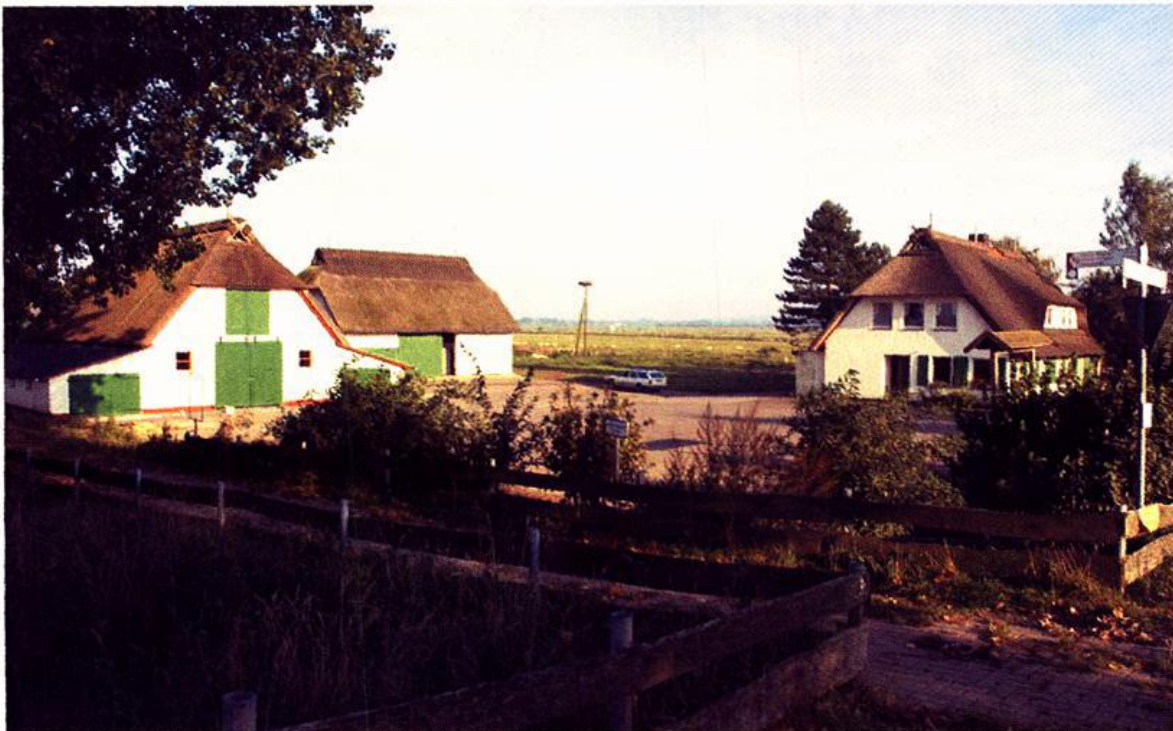
Abb. 5: Blick von der Huntebrücke auf den Schäferhof
