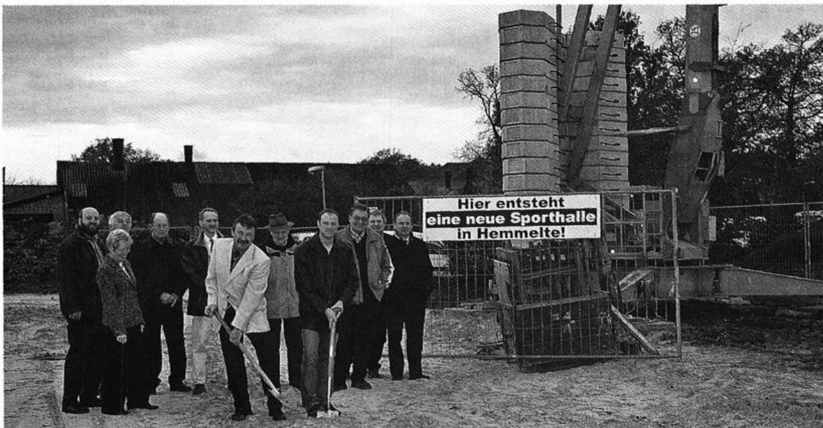
Spatenstich am 22. November 2006 für eine neue Turnhalle in Hemmelte; die Bevölkerung beteiligt sich mit 200.000 € und umfangreichen Arbeitsleistungen am Bau
