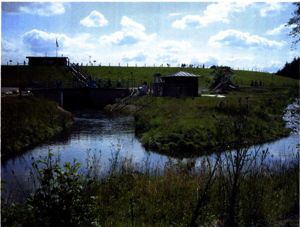
Abb. 4: Talsperrenableiter zur Soeste mit Pegelhaus
