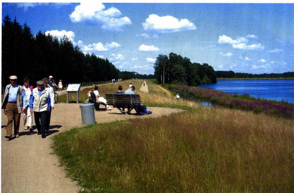
Abb. 6: Westlicher Staudamm mit Betriebswegen, Sitzgruppe und Röbricht
