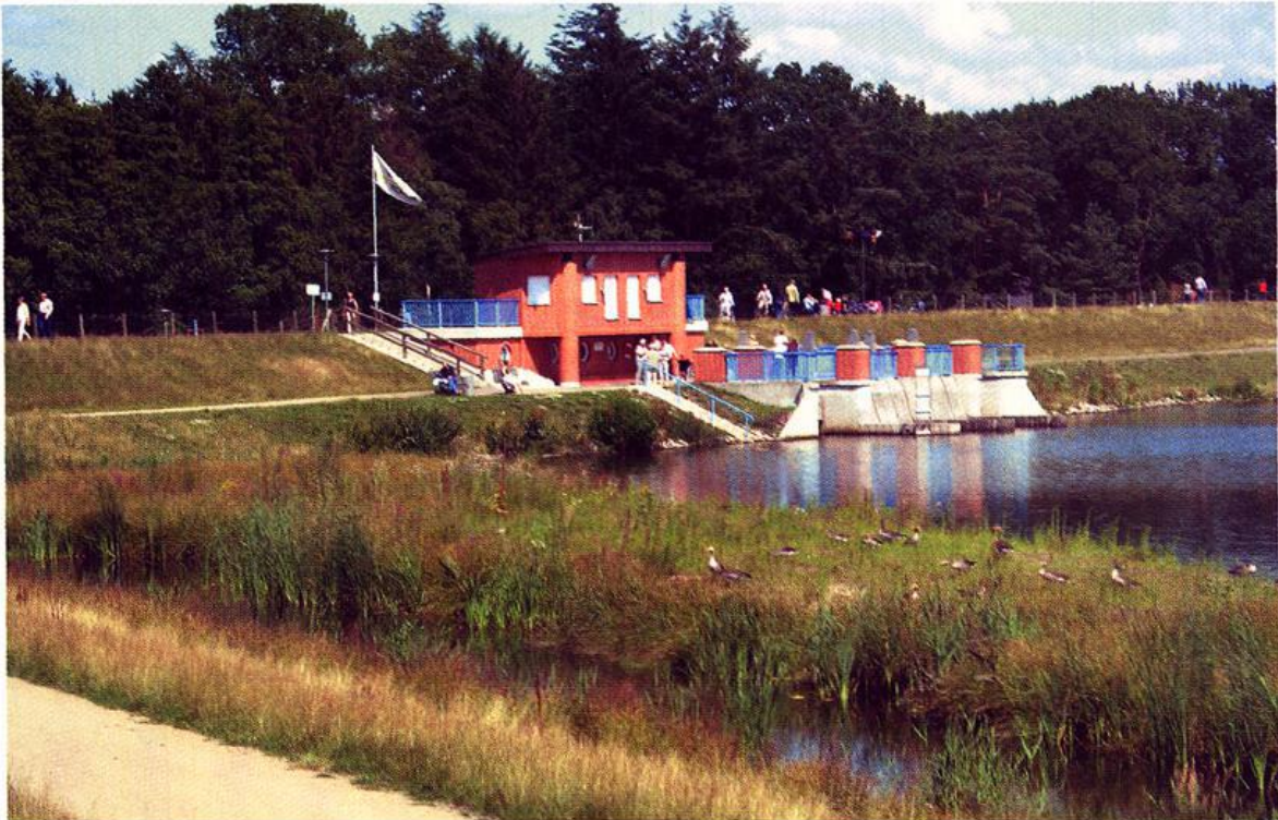
Abb. 2: Auslaufbauwerk mit Röhrichtinsel und Graugänsen
