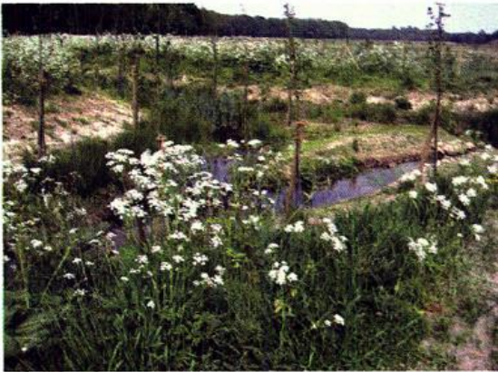
Abb. 4: Die neue Bachtrasse im Bereich der Einmündung des Hopener Waldbachs in den Hopener Mühlenbach am Ausbaubeginn der Renaturierungsstrecke
