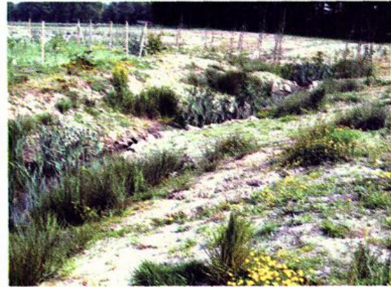
Abb. 5: Gut zu erkennen ist der den Abfluss hemmende Steinsporn im Unterlauf und die sukzessive Besiedlung des neuen Gewässerbettes durch Rohrkolben, Sumpf-Schwertlilie und Flatterbinse.
