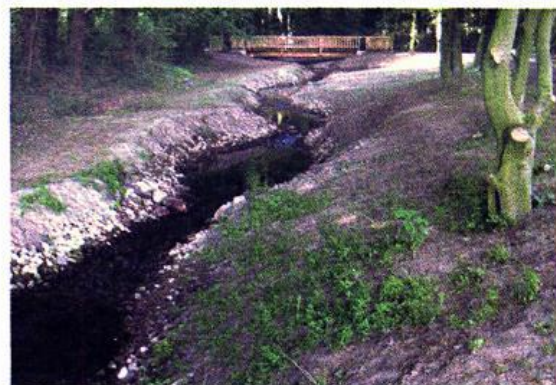
Abb. 9: Der ehemals vorhandene Soblabsturz mit Verrohrung ist einer Sohlgleite aus Schwellen und Ruhebecken gewichen. Dadurch wurde die Durchgängigkeit des Gewässers wieder hergestellt. Im Hintergrund ist eine neue Brücke für Unterhaltungsfahrzeuge und Naberholungsuchende zu erkennen.
