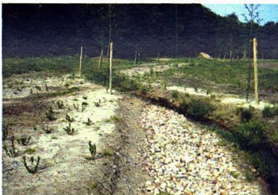
Abb. 8: Das neue Bachbett mit loser Sandsteinschotter-Schüttung im Gleitufer und Sohlenbereich mit randlicher Initialbepflanzung (Gilbweiderich und Ufersegge)
