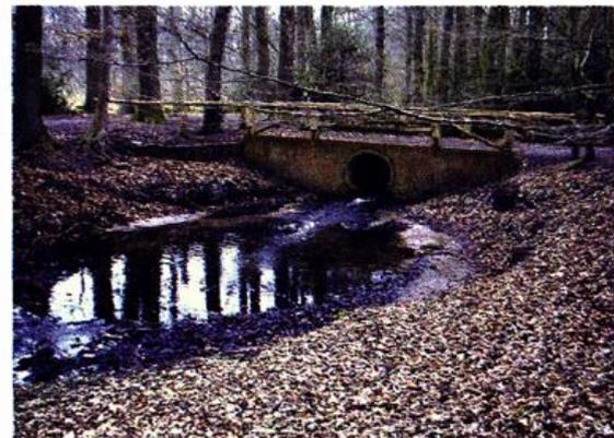
Abb. 3: Rohrdurchlass und Sohlabsturz am Ausbauende verhinderten die Durchgängigkeit des Gewässers.
