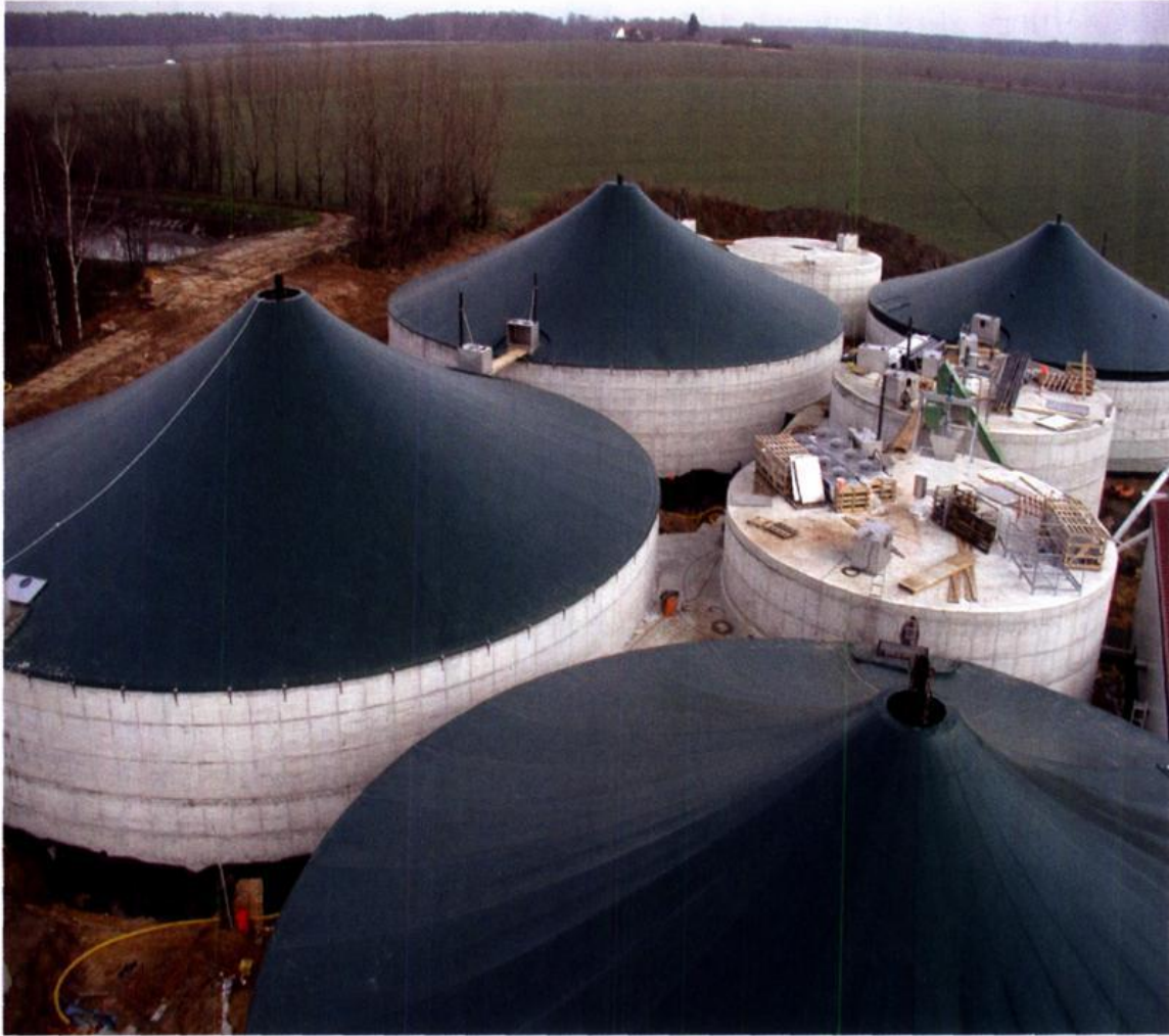
Abb. 3: Moderne Biogasanlage mit Blockheizkraftwerk
