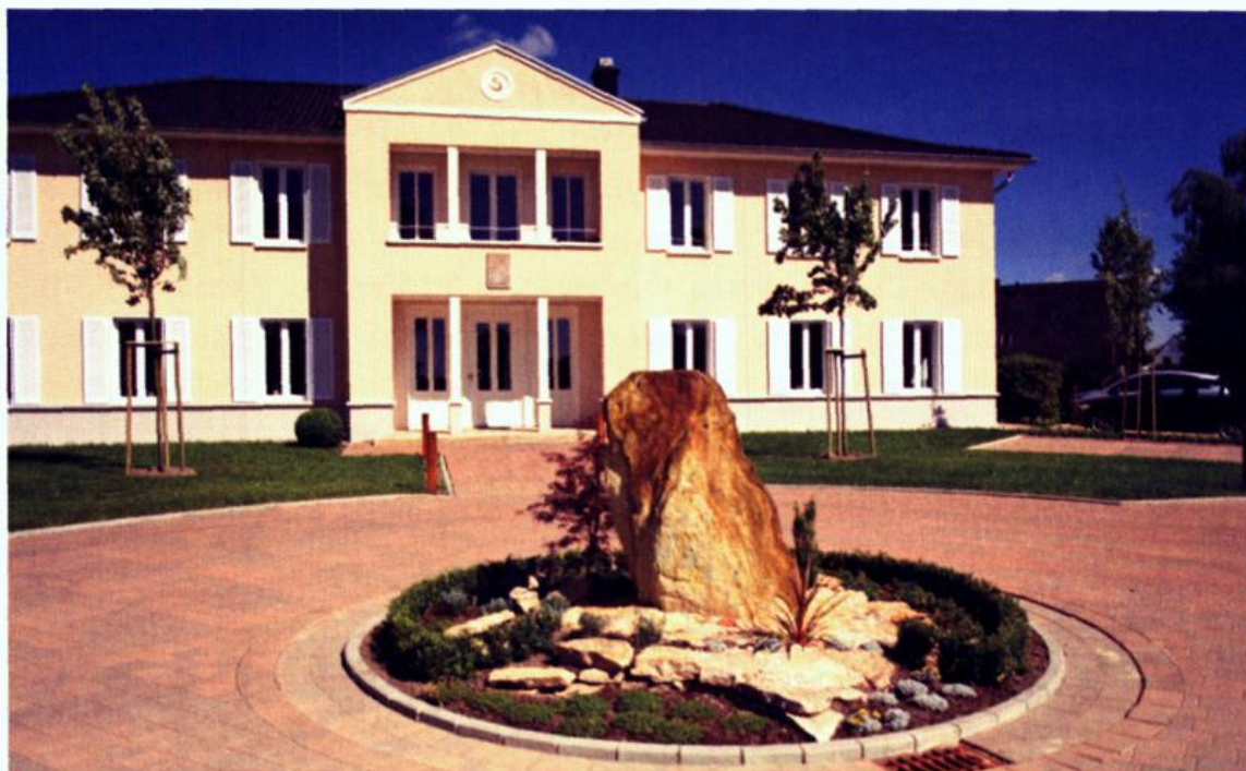
Abb. 8: Firmengebäude der Dr. Schwerdtfeger Personalberatung
