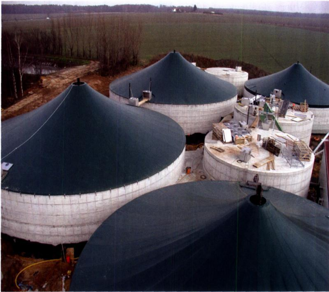
Abb. 3: Moderne Biogasanlage mit Blockheizkraftwerk
